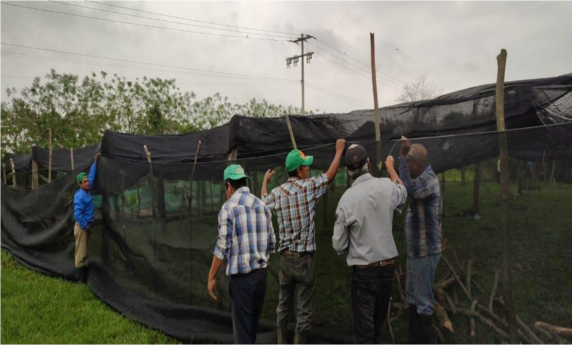
Figura.9 Instalación de malla protectora. Fuente: Con base a la información obtenida.
