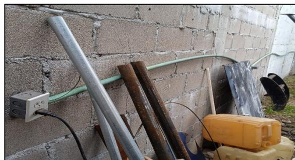
Fig. N°23 Mala condiciones inseguras del sistema eléctrico.
