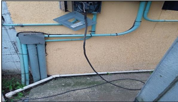
Fig. N°29 Conexión electricidad fuera del cableado.
