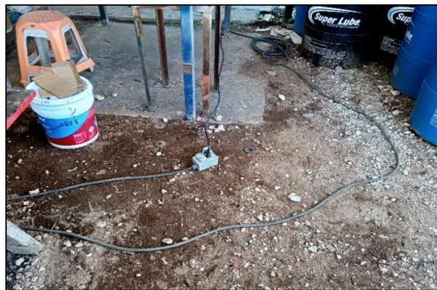
Fig. N°22 Extensión eléctrica inadecuada.
