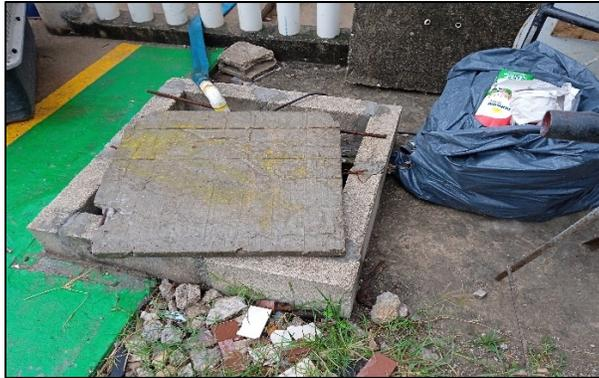
Fig. N°24 Tapa de drenaje mal colocada.
