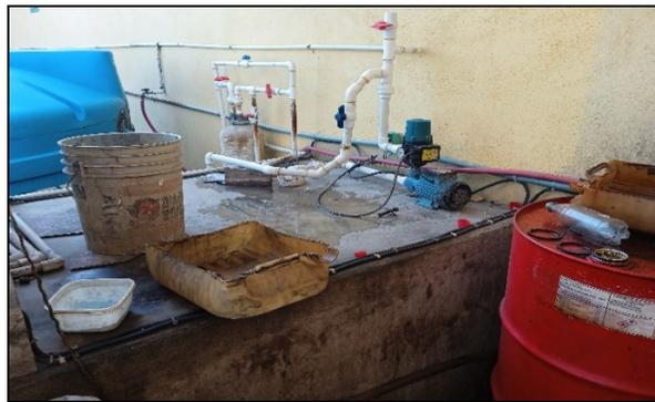
Fig. N°19 Suciedad en el sistema de agua.
