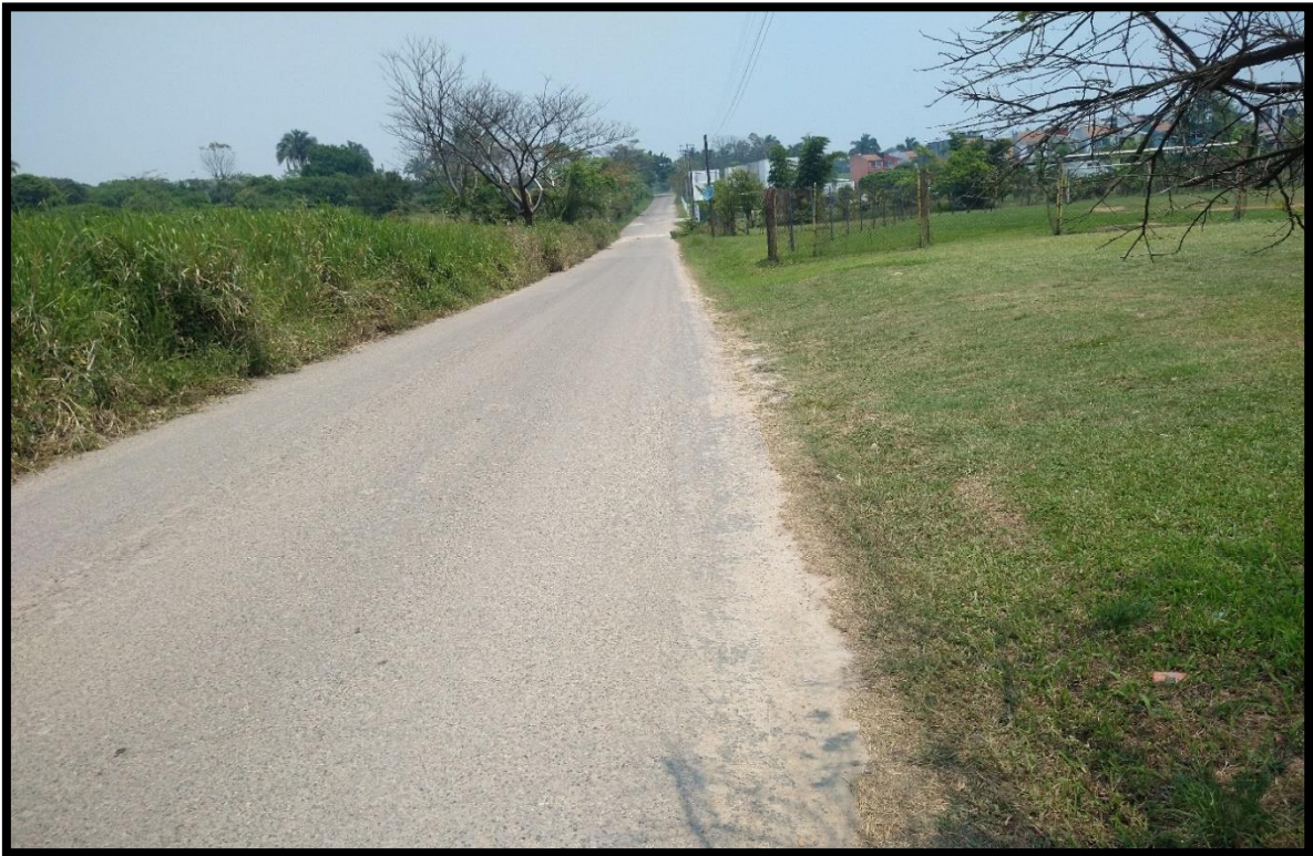
Figura 7. Falta de banquetas en el tramo carretero a la planta de lodo.
