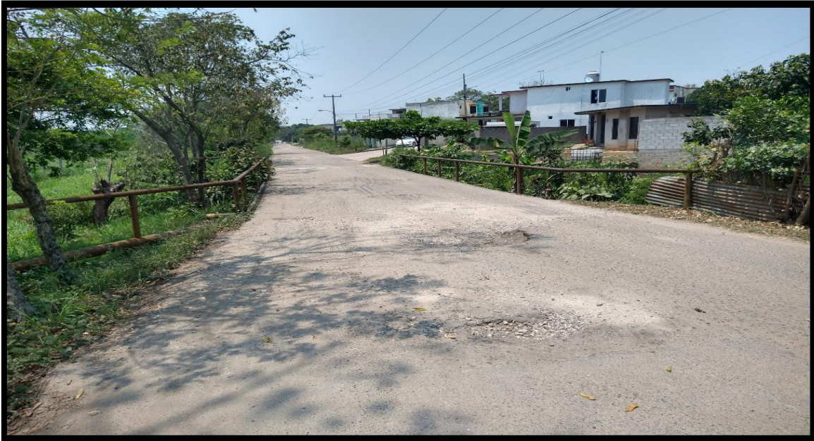
Figura 15. Barandales oxidados Fuente. Con base a la información obtenida
