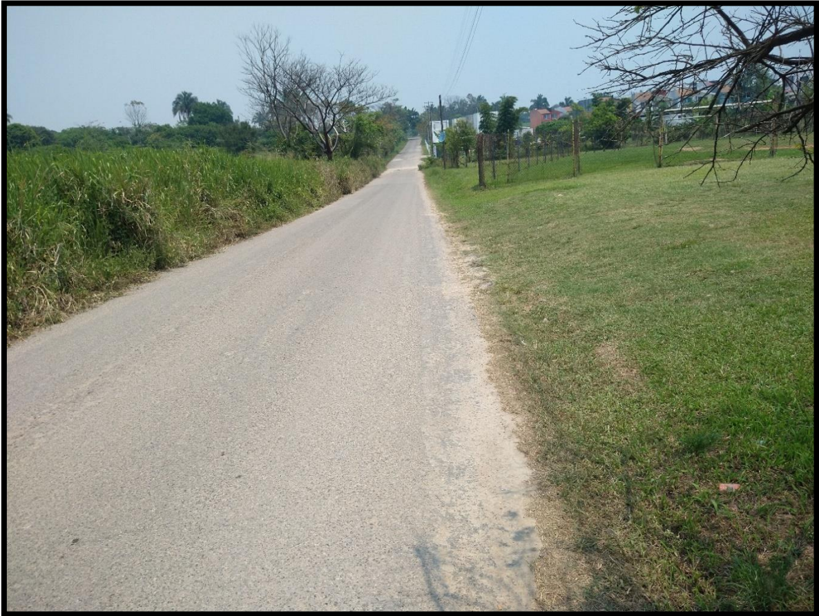
Figura 12. Falta de iluminación
