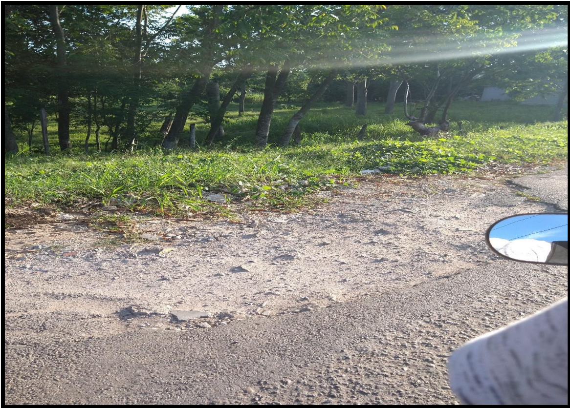
Figura 8. Rompimiento de la carretera.
