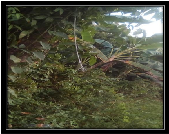
Imagen 13. Cables Reventados Del Poste De Luz
