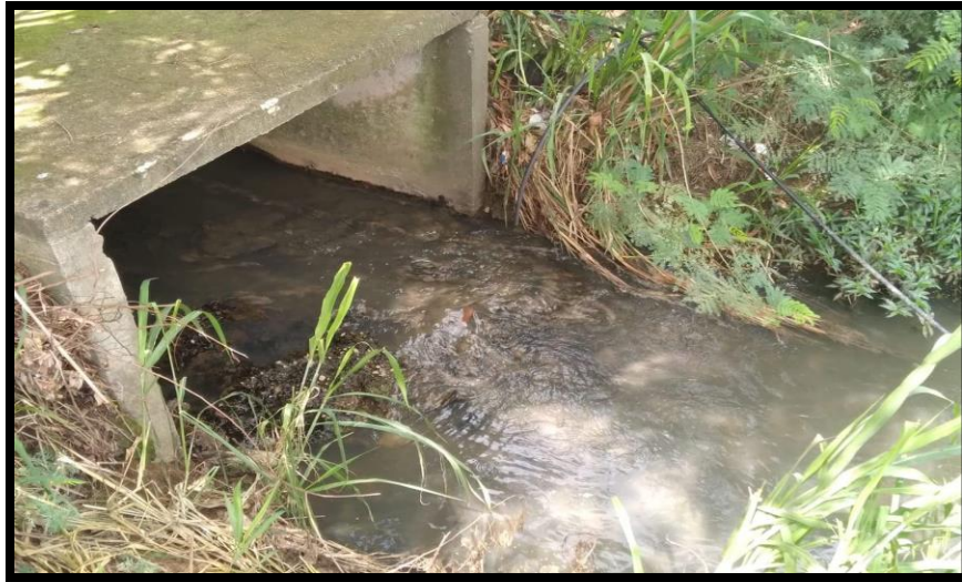
Figura 17. Arroyo que pasa por la colonia
