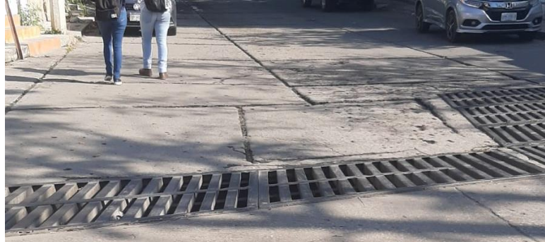
FIGURA 17: Pozo de visita 1 y 2, salida del canal embovedado sin función.
