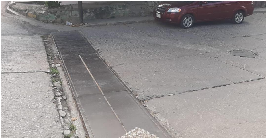
FIGURA 24: Pozo de visita 10. Acceso principal al canal embovedado.
