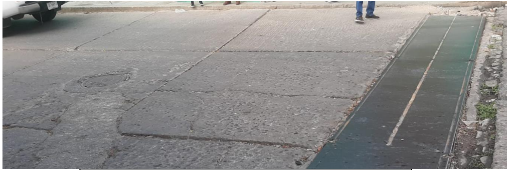
FIGURA 23: Pozo de visita 9.
