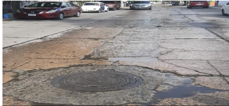
FIGURA 18: Pozo de visita 3. Imagen obtenida en campo
