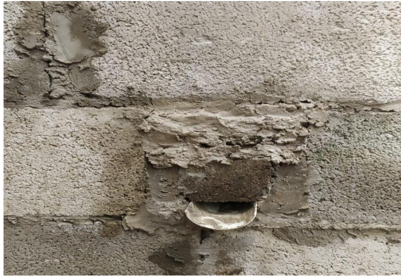
Figura 4: Tubo de salida para la recolección de lixiviados
