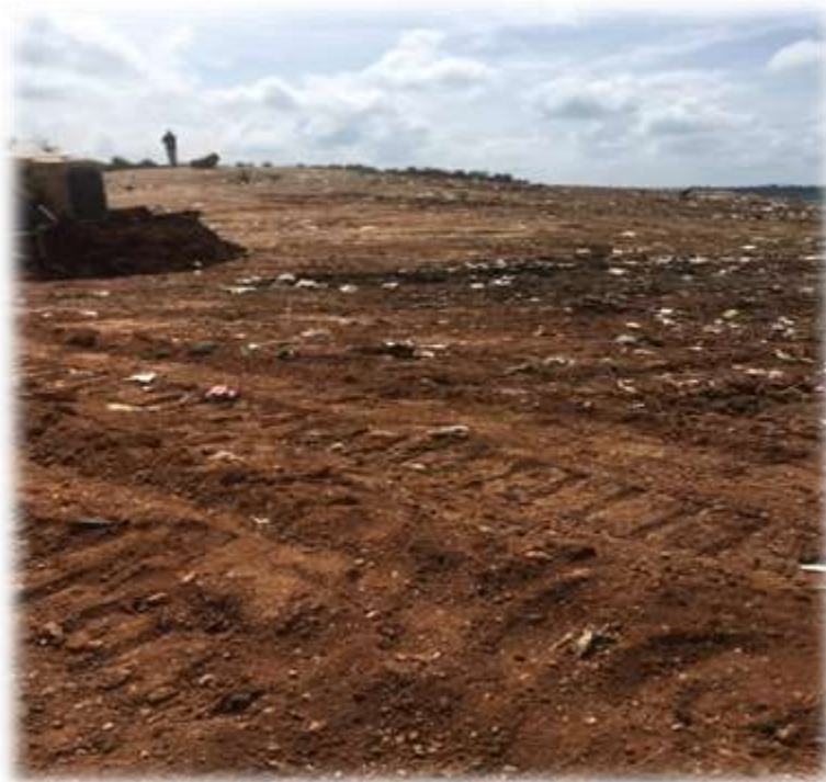
Figura 3. Celda del RS de Chiapilla.
