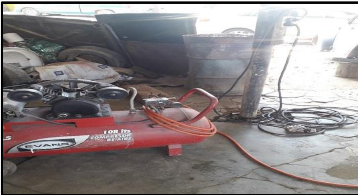
Figura 153 Cables extendidos en el suelo en el Taller Hojalatería y pintura Don Goyo
