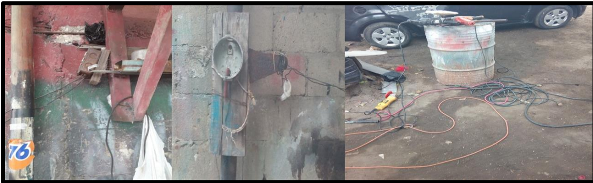
Figura 46 Cableado en mal estado
