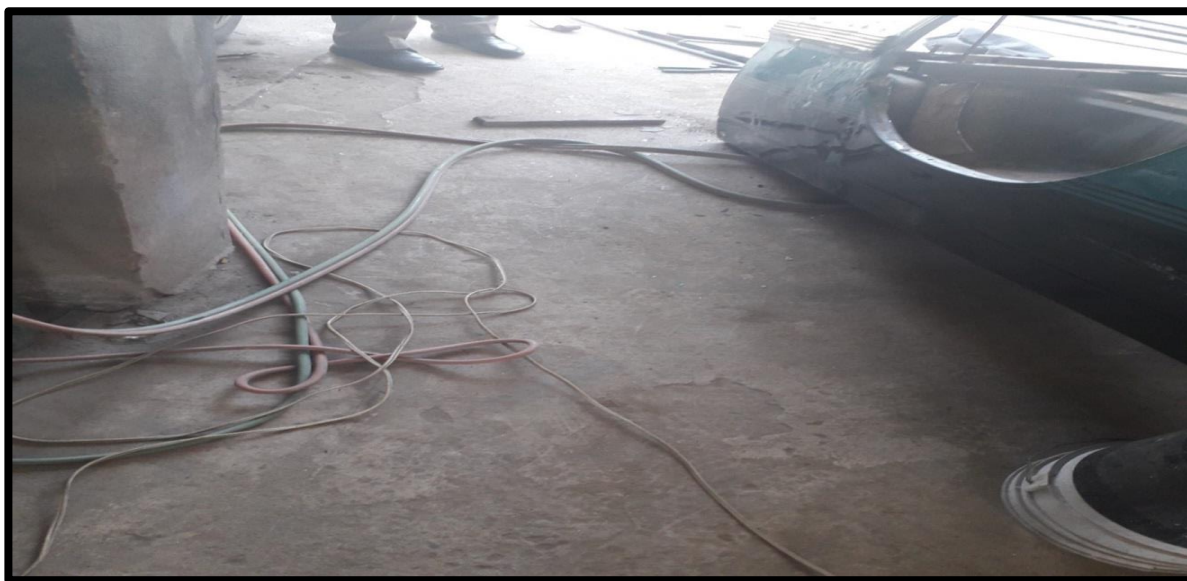
Figura 56 Cables y mangueras sueltas Taller Trino
