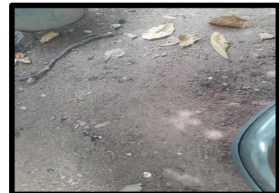
Figura 77 Piso de tierra mojado Taller El Mosco Fuente: con base a la información obtenida
