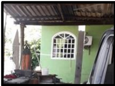
Figura 105 Falta de señalización de seguridad Taller Don Goyo Fuente: con base a la información obtenida
