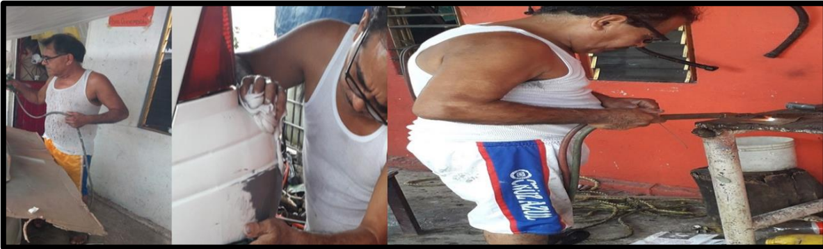
Figura 23 aplicaciones de pintura, lijado y soldadura
