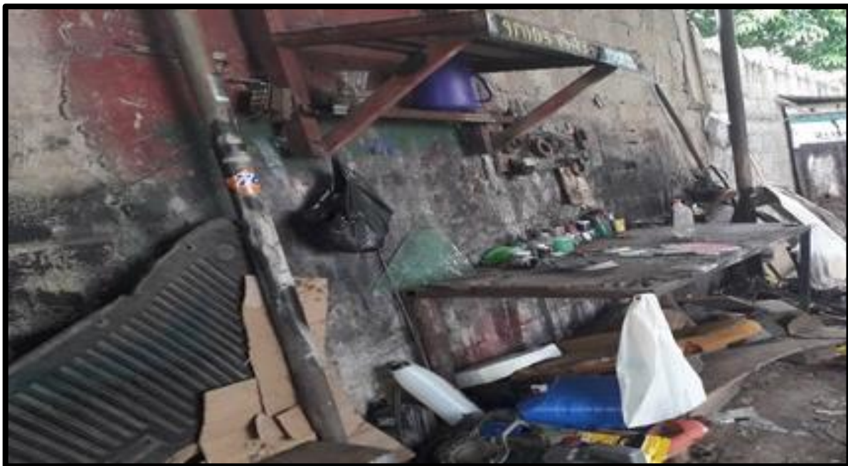
Figura 157 Falta de limpieza en el Taller Hojalatería y pintura El Flaco
