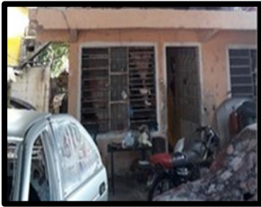
Figura 91 Falta de extintor Taller Servicios González Fuente: con base a la información obtenida
