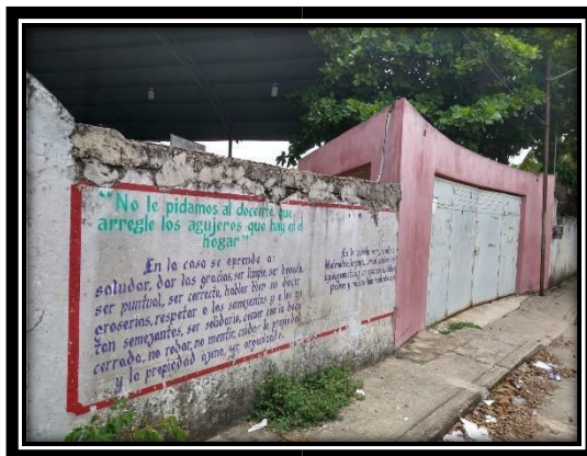
Figura 13: Muro o pared de la primaria
