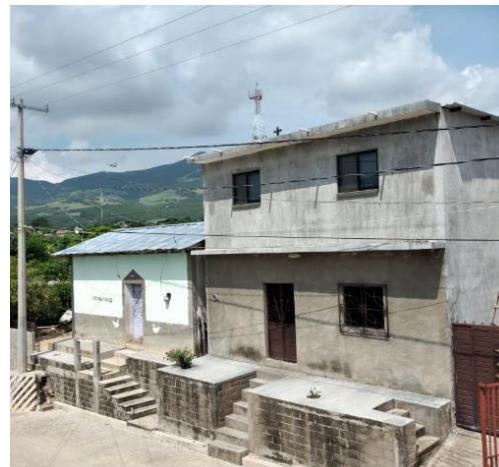
Fotografía 12. Casa con techo de láminas
