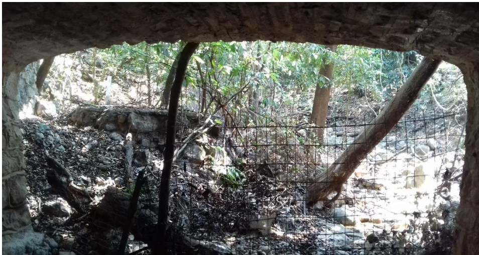
Foto 6. Sendero parte baja de la Reserva. Bloqueo insuficiente para la protección de intrusión. UTM; Log. 489624 N, Lat. 1849220 W a 674 msnm. Reserva Ecológica El Zapotal, Tuxtla Gutiérrez, Chiapas.
