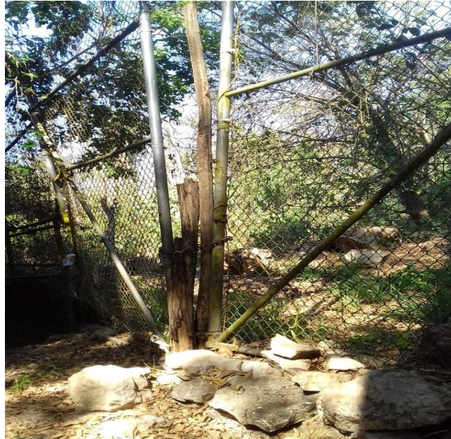
Foto 7. Portón de tubo galvanizado de 38 mm con malla ciclónica, en malas condiciones de seguridad, con troncos de árbol y en la parte inferior tapada con piedras de diferentes tamaños. UTM: Long. 490068.9 N, Lat. 1849005.9 W a 711 msnm. Reserva Ecológica El Zapotal, Tuxtla Gutiérrez. Chiapas.
