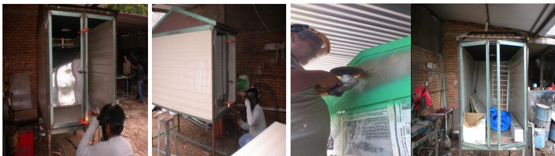
Figura 4.7 Fotos del proceso de construcción.
