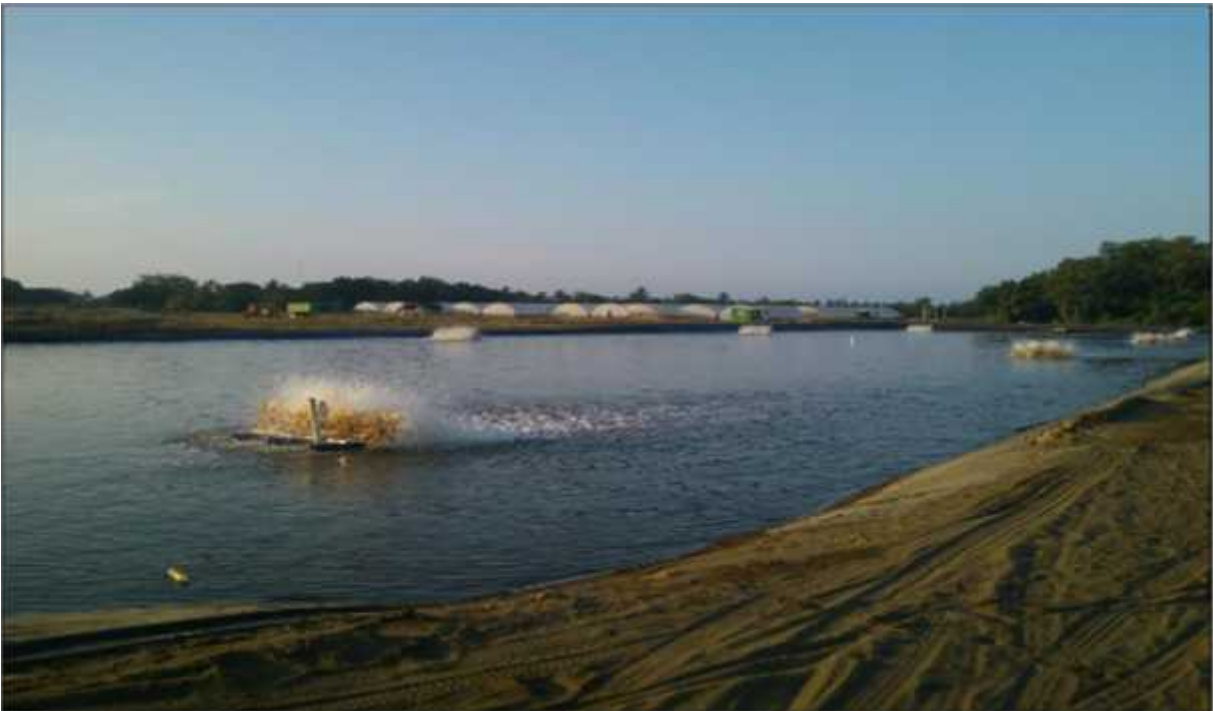
Figura 14. Oxigenación del estanque a través de aireadores de paletas.
