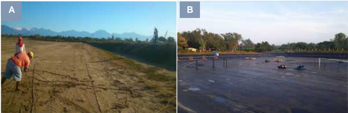
Figura 6. Preparación de estanques de engorda. A) estanque de tierra. B) estanque de liners negro.
