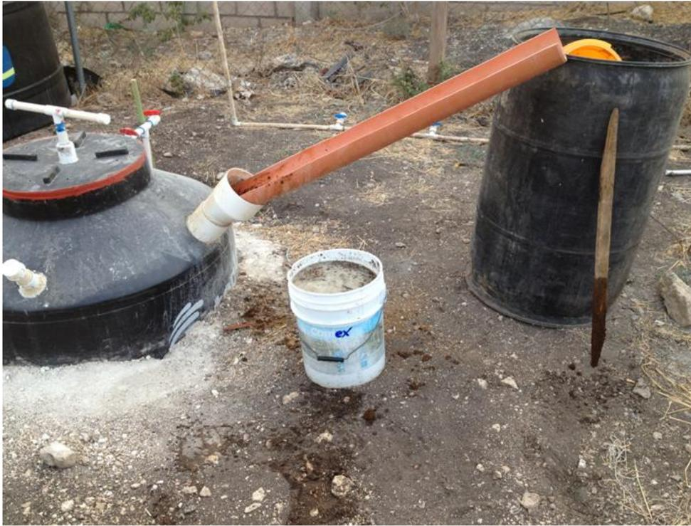
Figura 21. Vaciado de la mezcla de estiércol con agua, dentro del biodigestor. Fotografía, Gómez (2013).
