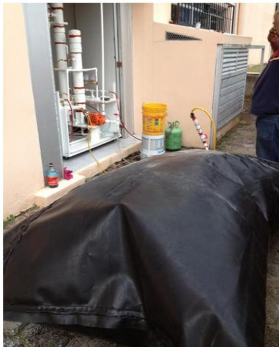
Figura 31. Bolsa de geomembrana instalada al módulo de acondicionamiento y presurizado de biogás. Fotografía, Gómez (2013).
