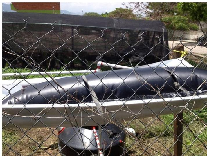
Figura 23. Bolsa de geomembrana llena de biogás. Capacidad 1.5 m<sup>3</sup>. Fotografía, Gómez (2013).
