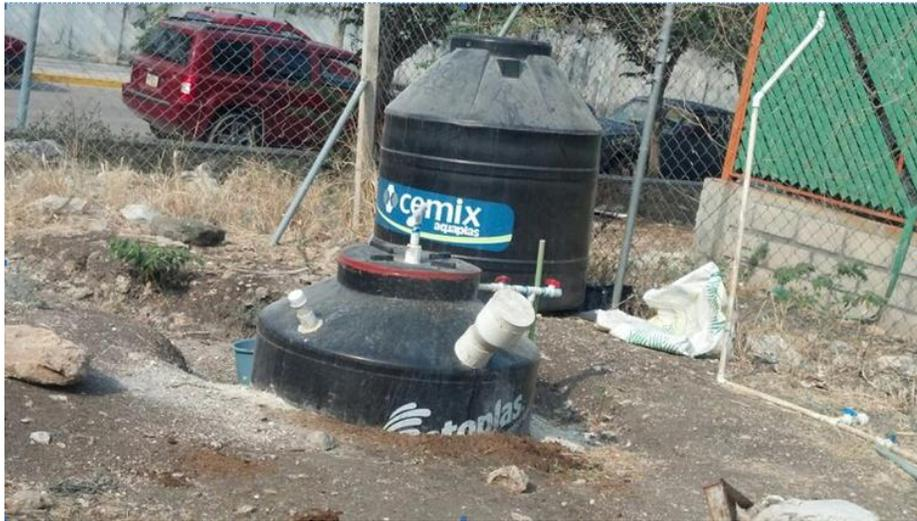
Figura 16. Biodigestor instalado dentro de la UNICACH, en Tuxtla Gutiérrez, Chiapas. Fotografía, Gómez (2013).
