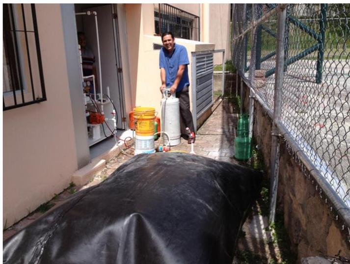
Figura 22. Bolsa de geomembrana con biogás, capacidad 3.5 m<sup>3</sup>. Fotografía, Gómez (2013).
