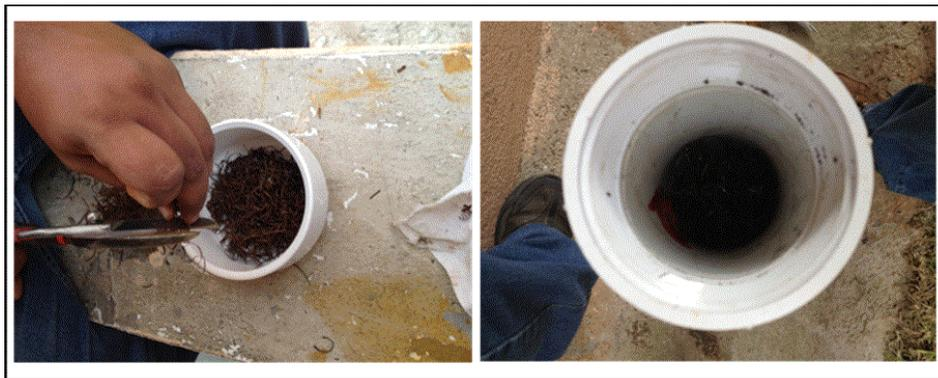
Figura 14. Colocación de la limadura de hierro tratada en el Filtro Seco. Fotografía, Gómez (2012).
