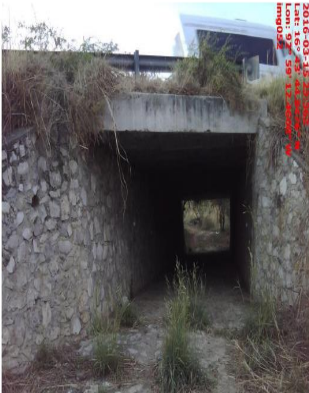
Fotografía No. 1.9 obra de drenaje del km 4+034.08
