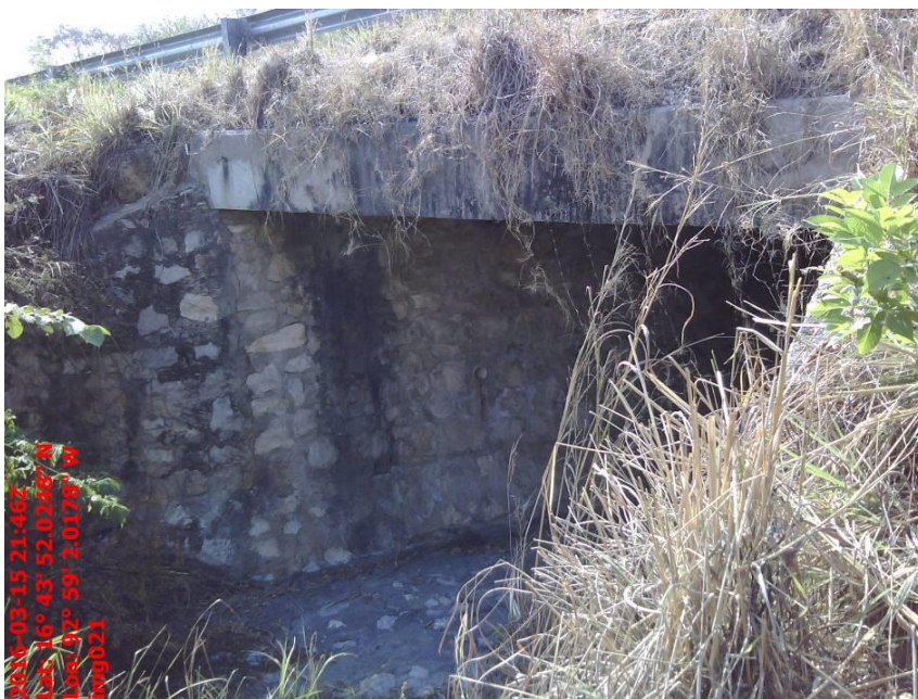
Fotografía No. 3.3 Alcantarilla con Losa de Concreto Armado en el Kilómetro 4+240.22
