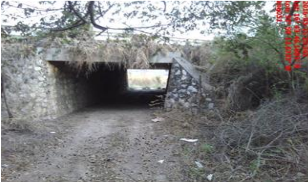
Fotografía No.3.1 Paso de Ganado con Losa de Concreto Armado en el Kilómetro 3+872.33.
