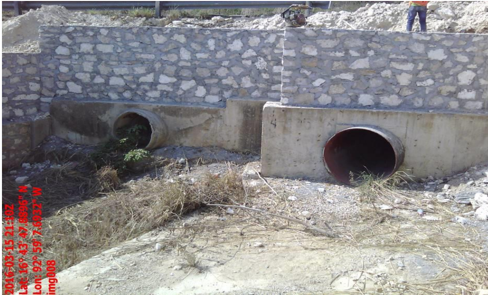
Fotografía No. 3.2 Se aprecia la obra de Drenaje con un Tubo de Concreto de 35"; en el kilómetro 4+034.08 y un Tubo Galvanizado de 47" en el kilómetro 4+038.56
