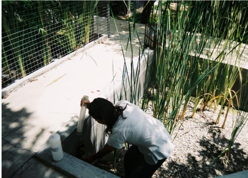
Figura 15. Verificación de la salida del efluente (ARS tratada) del Sistema Integral anaerobio-humedal.
