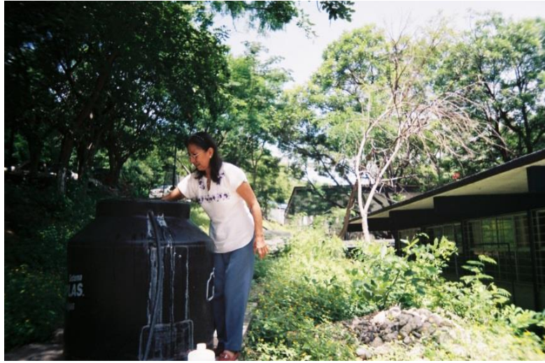
Figura 13. Verificación de la carga y libre acceso del flujo de ARS del Sistema Integral anaerobio-humedal en tanque alimentador Rotoplas®.
