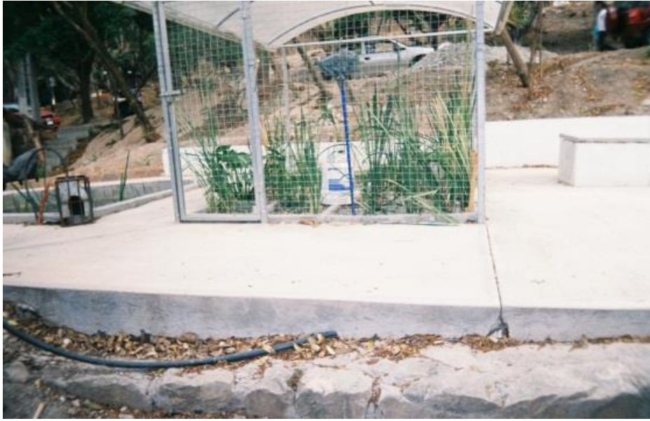
Figura 8. El Humedal del Sistema Integral anaerobio-humedal donde es tratada el agua de salida del biodigestor.
