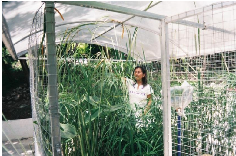
Figura 14. Verificación del nivel y flujo de ARS tratada por el biodigestor en el humedal, así como la poda de plantas maduras del Sistema Integral anaerobio-humedal.
