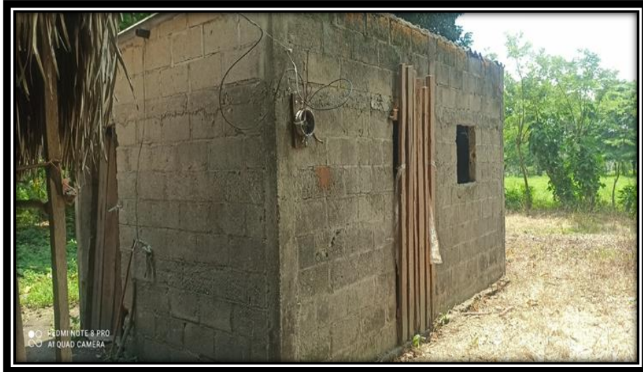
Figura 17: Vivienda en obra negra.
