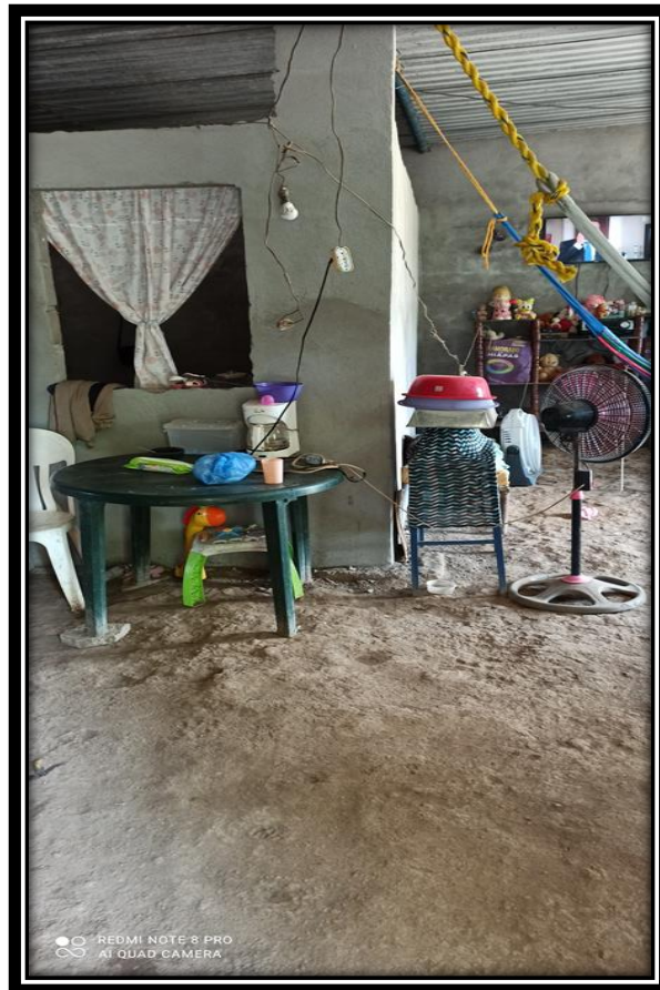
Figura 19: vivienda sin piso firme
