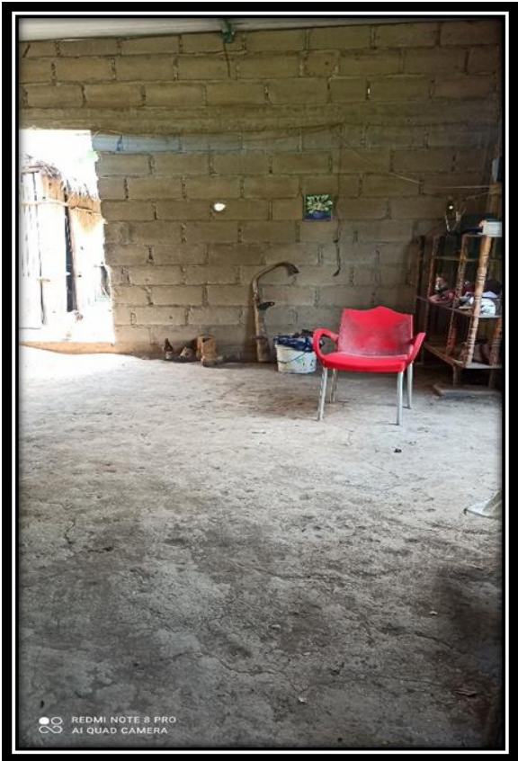
Figura 23: sala de una vivienda en obra negra Fuente: con base a la información obtenida
