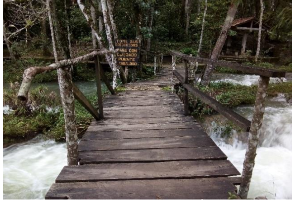
Fotografía propia: Andadores de la cascada
