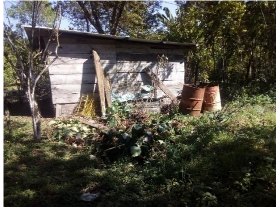
Fotografía propia: Deposito de materiales sin utilización
