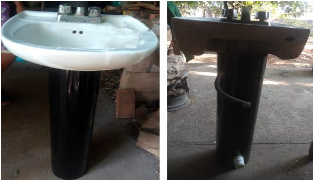
Ilustración 7- Diseño de lavabo estructurado con materiales de reusó, se muestra la adaptación del desagüe, así como la tubería de abastecimiento.
