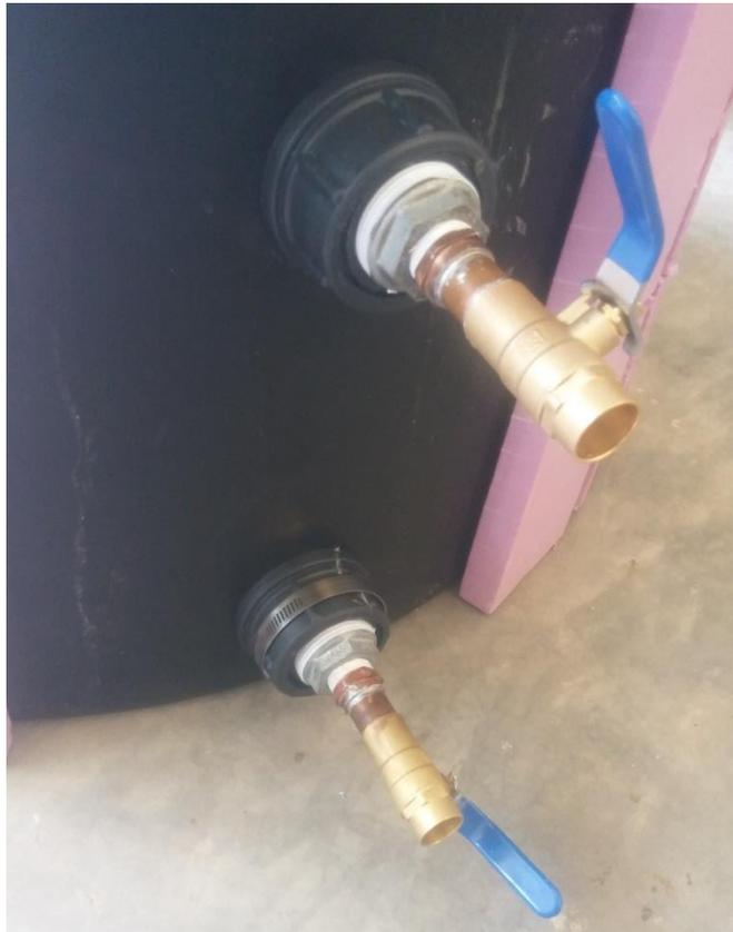
Las llaves de paso colocadas como se muestra en la figura serán para comprobar las temperaturas de entrada y salida de agua en el sistema.
