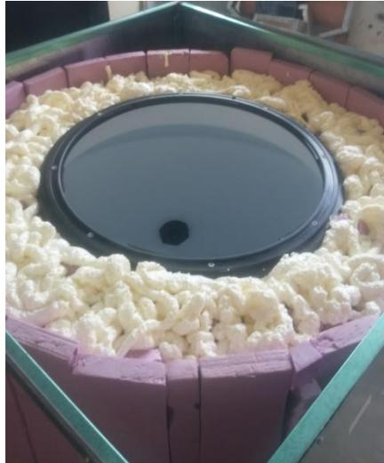
Paso 13. Hacer una estructura con las medidas adecuadas para introducir el tinaco aislado y posteriormente cubrirla con lámina galvanizada.
