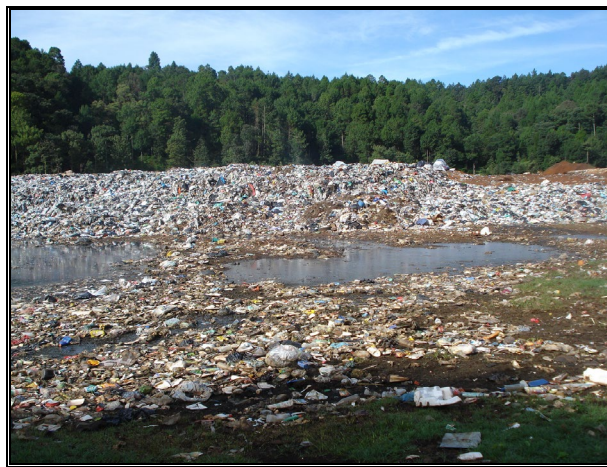
Figura 1. SDF con afloramiento de lixiviados en San Cristóbal de las Casas, Chiapas.
