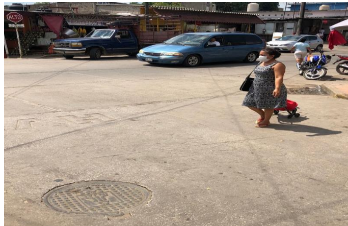
Figura No. 41: Deterioro de señal de cruce Fuente: Con base a la información obtenida
