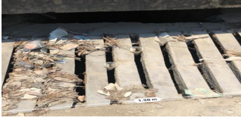
Figura No. 43:Obstrucción de drenaje Fuente: Con base a la información obtenida
