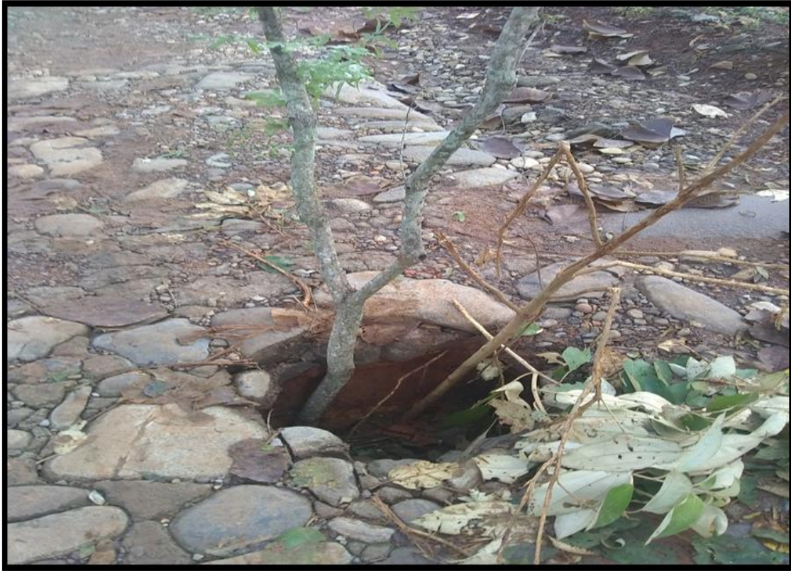
Figura 9. Alcantarilla rota
