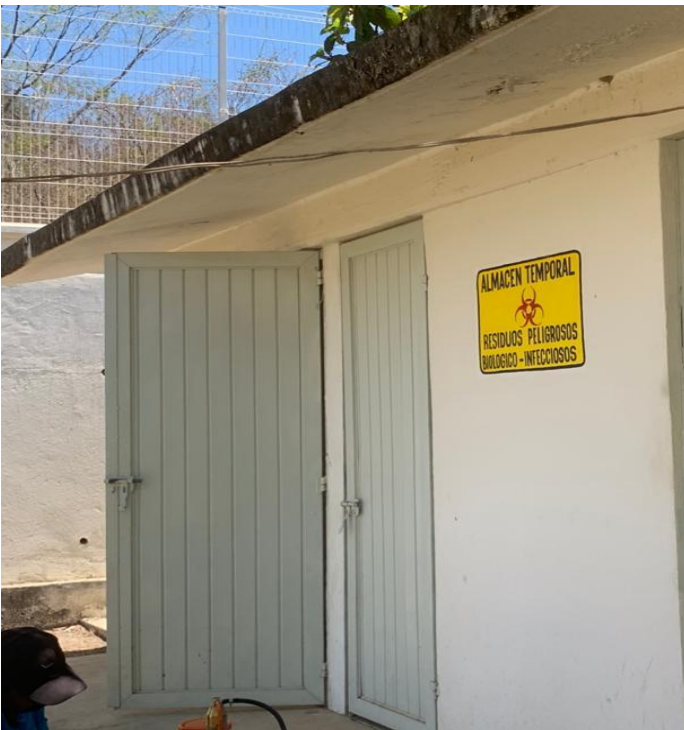
Imagen 6. Almacén temporal, inapropiado (Fuente propia)
