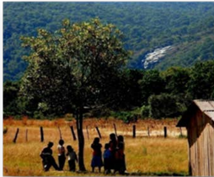
Cascada con potencial para producción de energía minihidráulica
