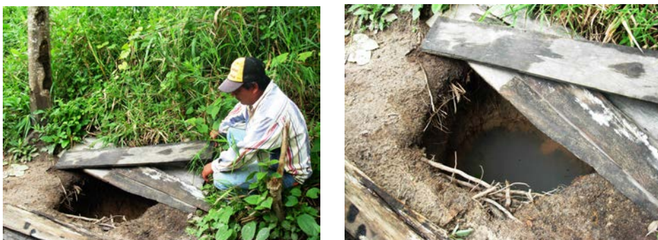
Figura 3.2.7. Pozo artesiano utilizado para consumo humano. Ubicado en la parte norte de la comunidad. Foto: N. Farrera
