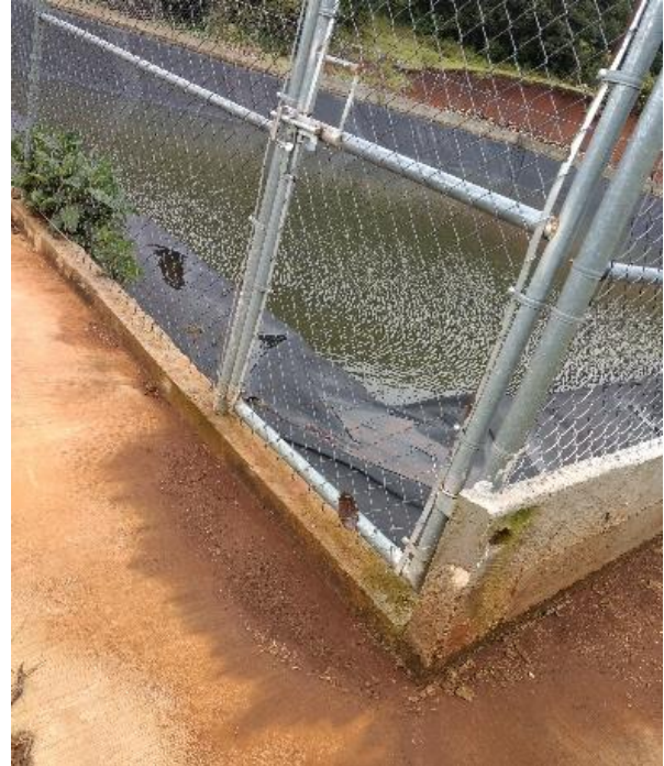
Figura 6. Vista de la diferencia de alturas del muro de la olla a
