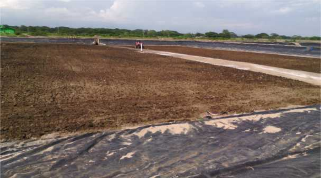
Figura 8. Preparación de los estanques por medio de rastreo con tractor para la adecuación de suelos.
