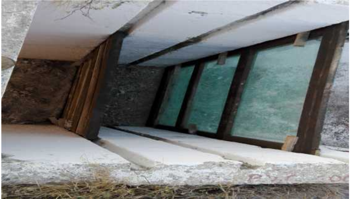
Figura 11. Compuerta totalmente sellada con sebo para no permitir paso de agentes extraños a los estanques de engorda.
