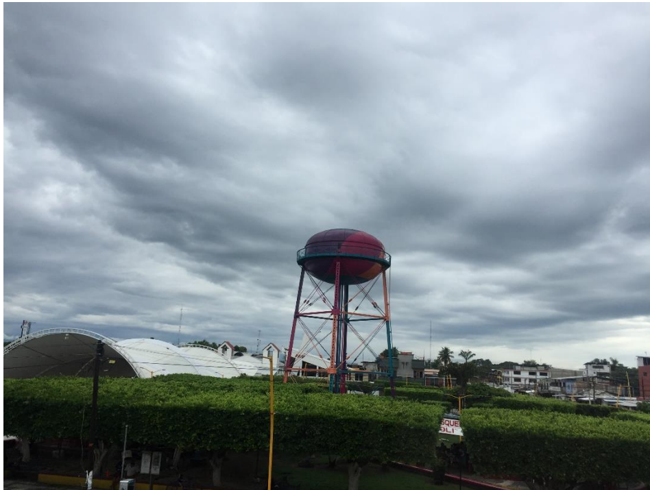
Fotografía 15. Tanque elevado en Ciudad Hidalgo
