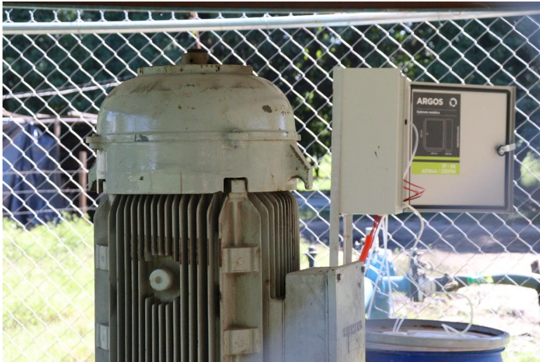
Fotografía 7. Motor vertical pozo Vista Alegre
