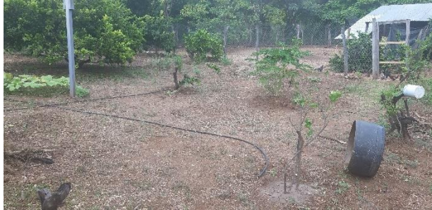
Imagen 12. Limpieza de terreno
