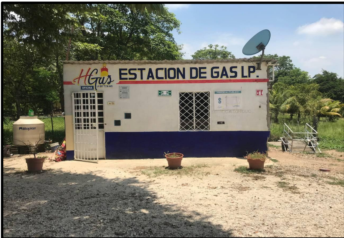
Figura 19 Gasera 2: H Gas
