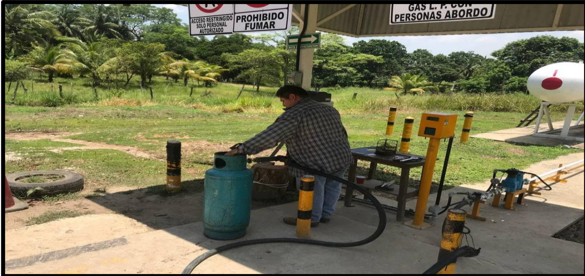
Figura 22 Se abre la válvula del tanque para comenzar con su llenado
