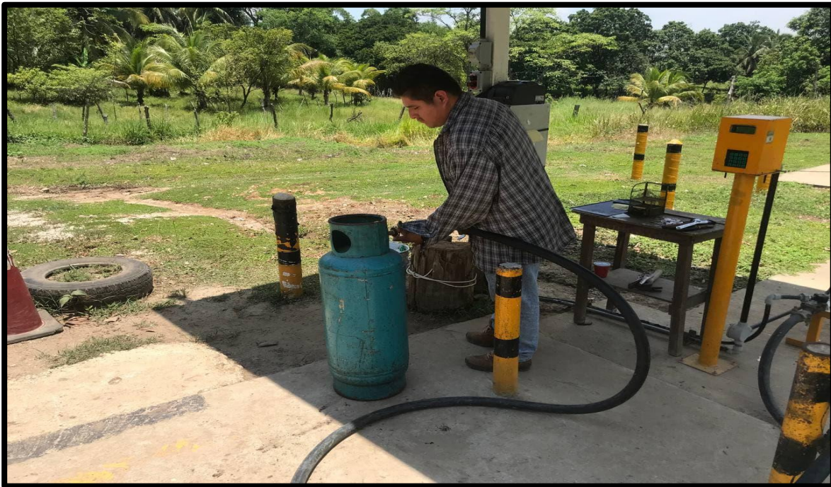
Figura 21 El trabajador conecta la manguera al tanque
