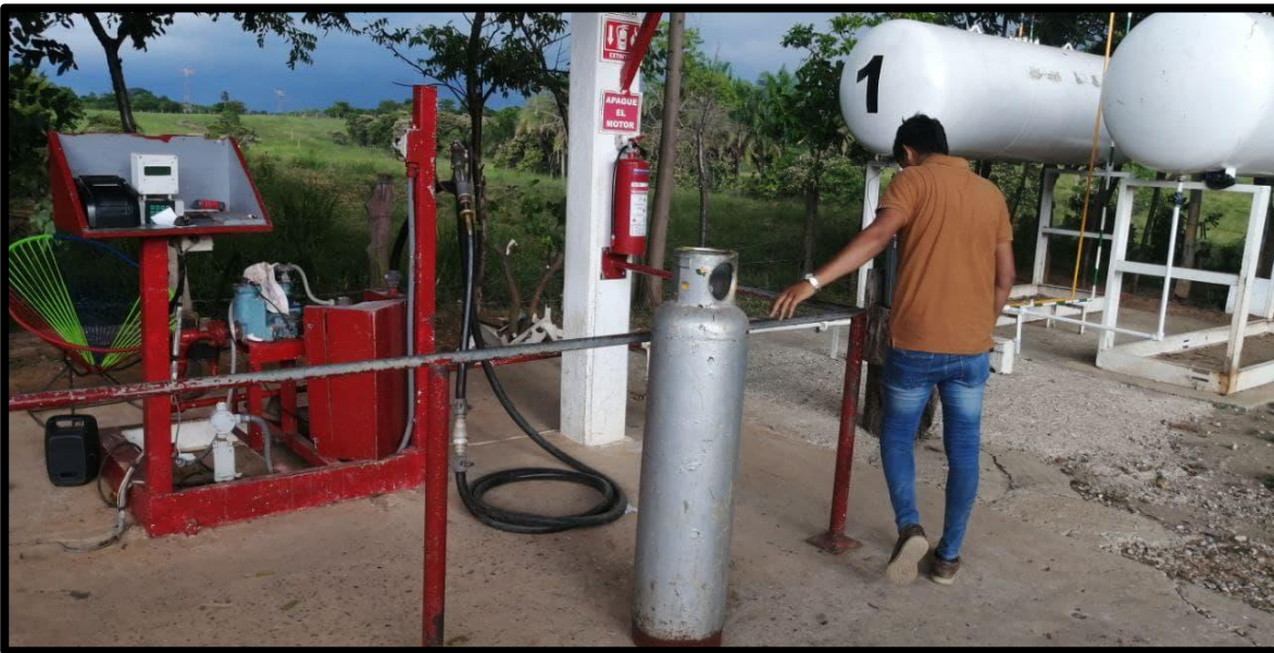
Figura 16 El trabajador se dirige a tomar la manguera para conectarla al tanque
