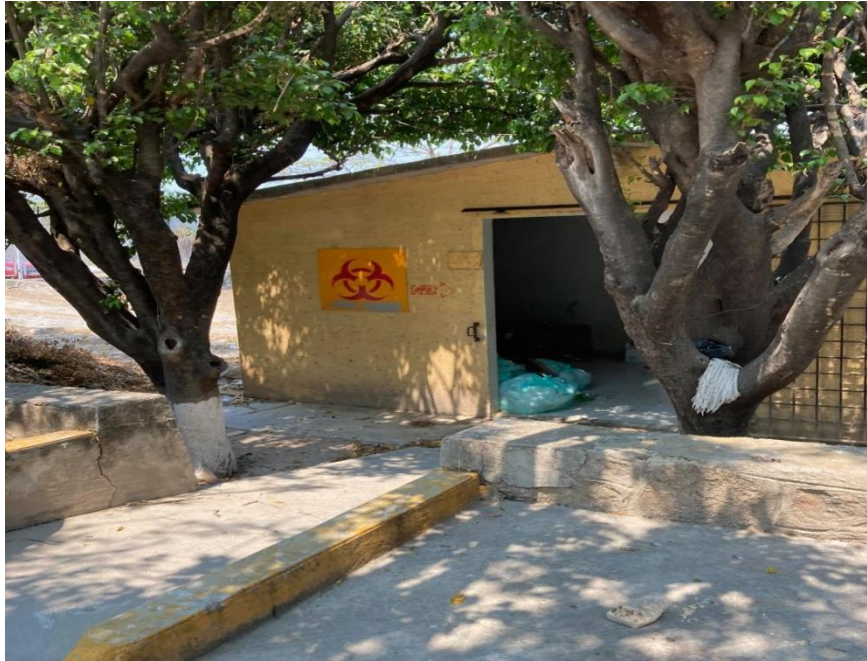
Ilustración 2. Almacén temporal. Fuente propia
