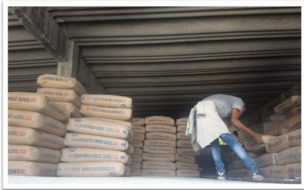
Figura 13. Acomodo de los costales de cemento
