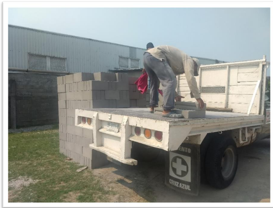
Figura 8. Acomodo de blocks en el transporte de materiales
