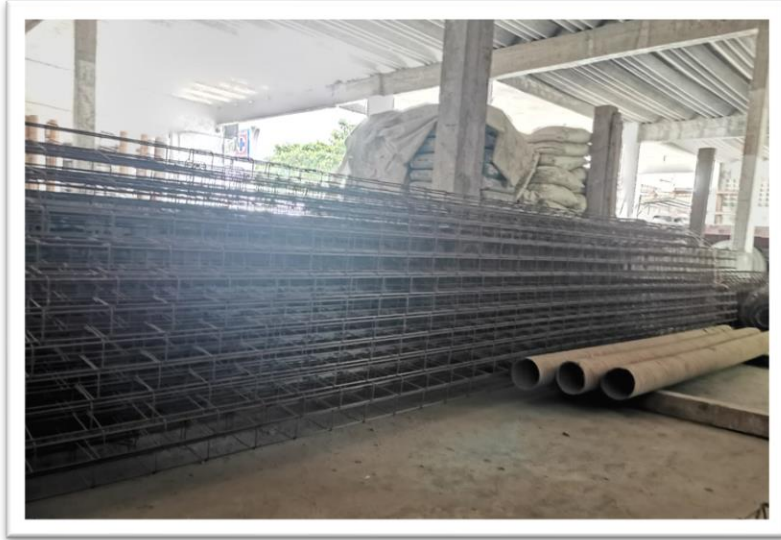
Figura 24. Castillos para concreto
