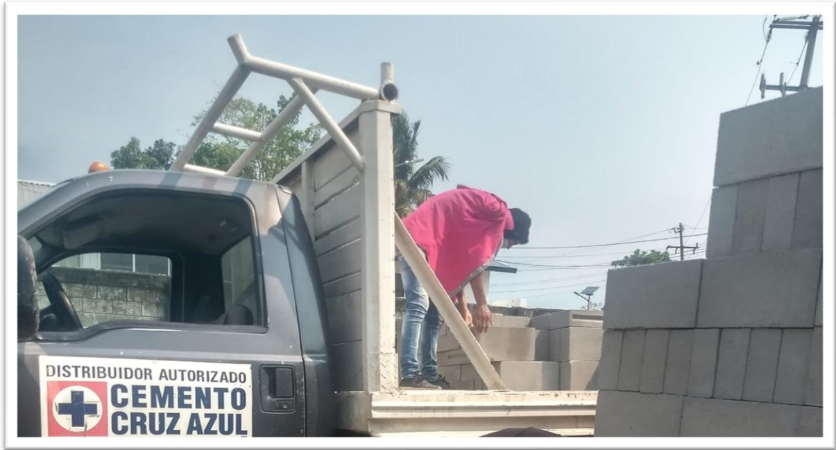
Figura 10. Traslado y acomodo de blocks en la unidad de transporte
