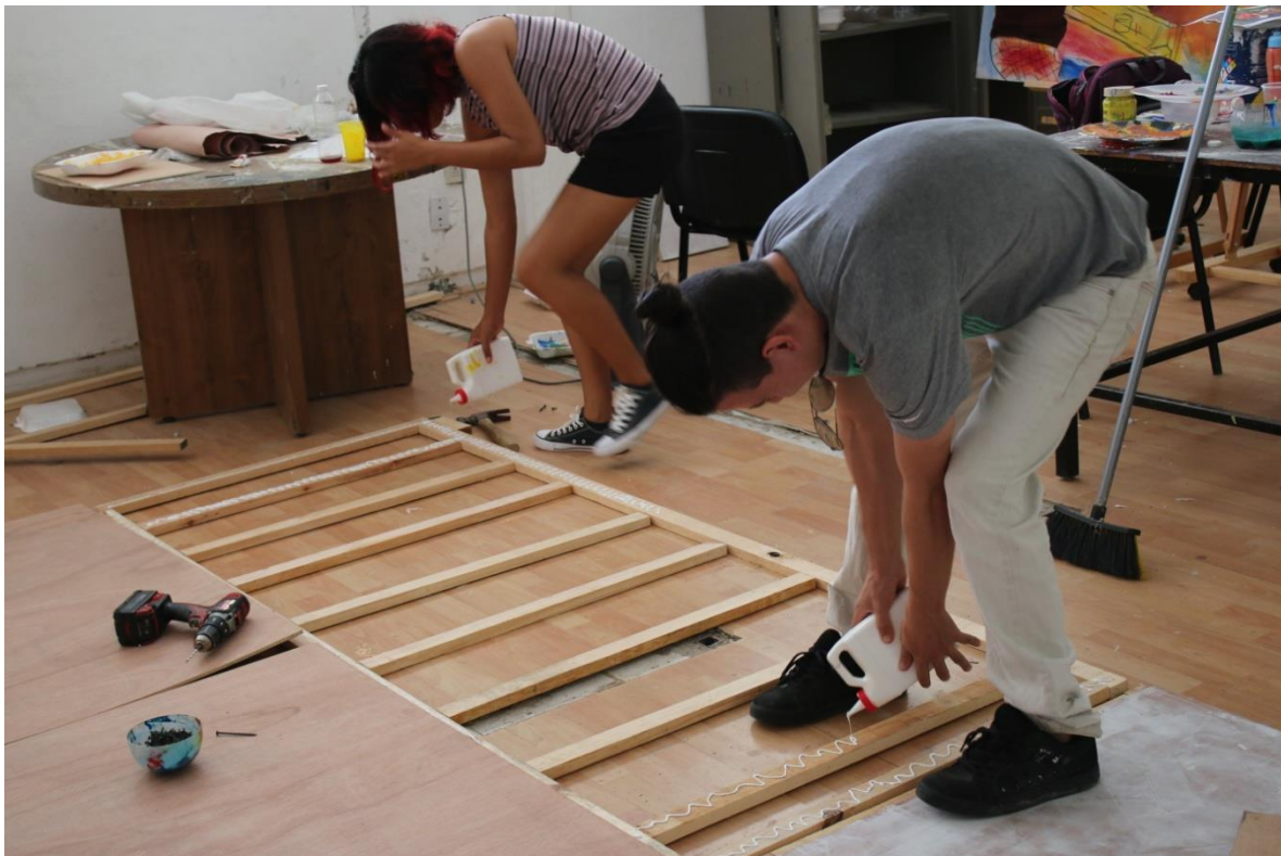
Armado de paneles. HP Rojas. 2018
