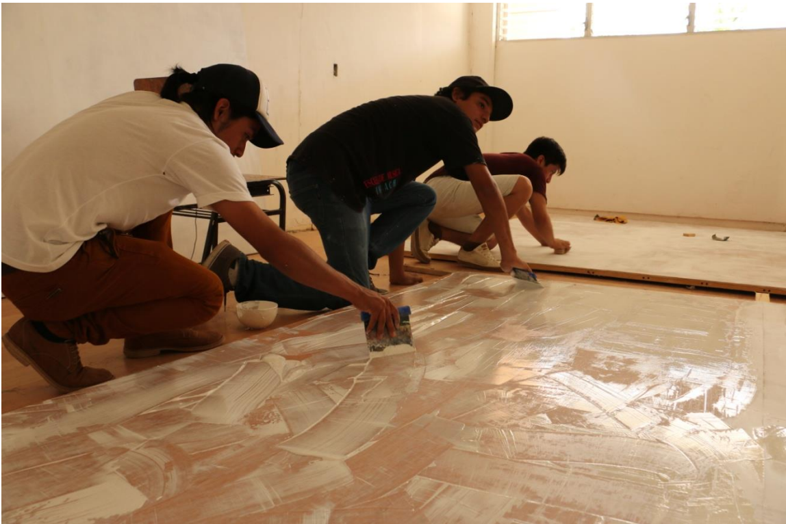
Aplicación de Plastilita sobre el panel. HP Rojas. 2018
