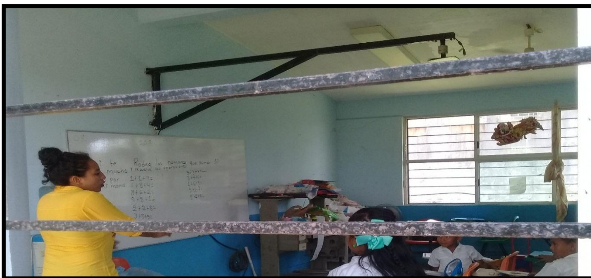
Figura 13. Instalaciones eléctricas escuela primaria Benito Juárez Fuente: Con base a la información obtenida.
