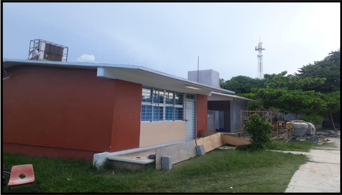
Figura 6 Aula nueva sin señalamiento
