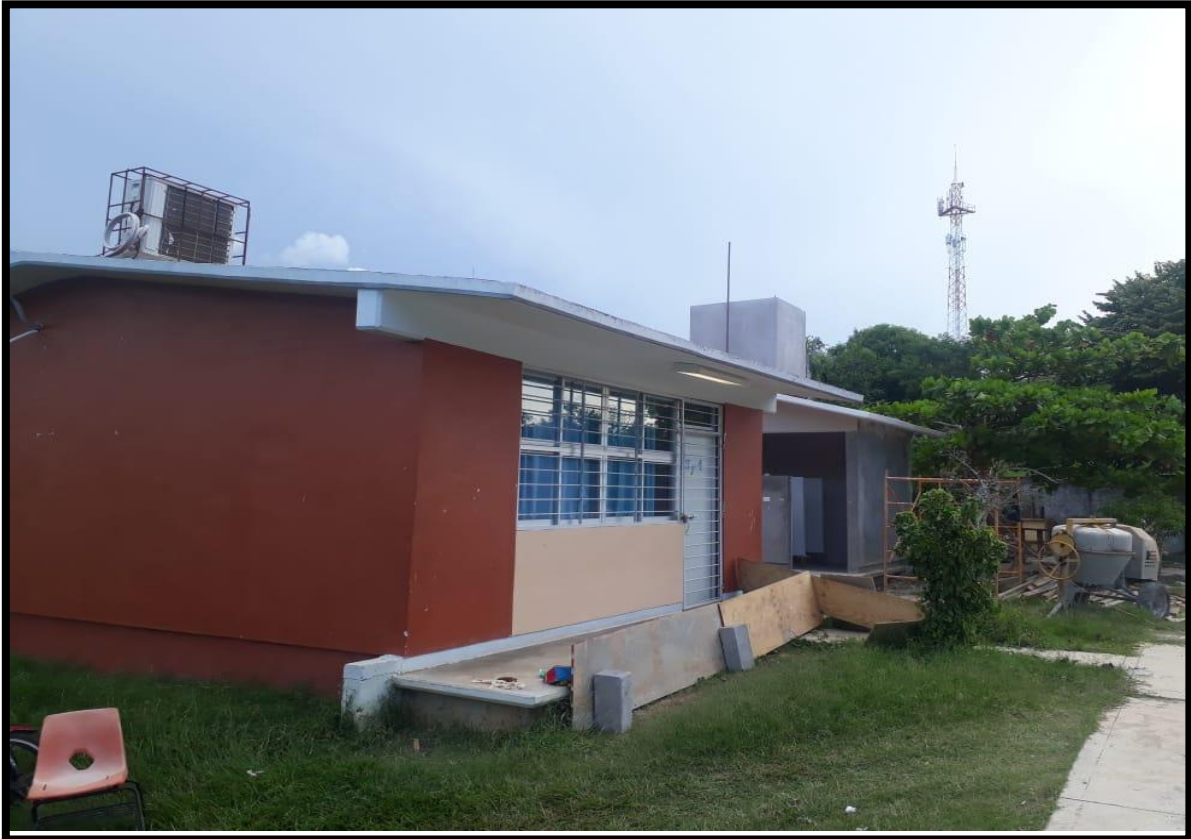
Figuran 9 Tablas obstruyendo pasillo
