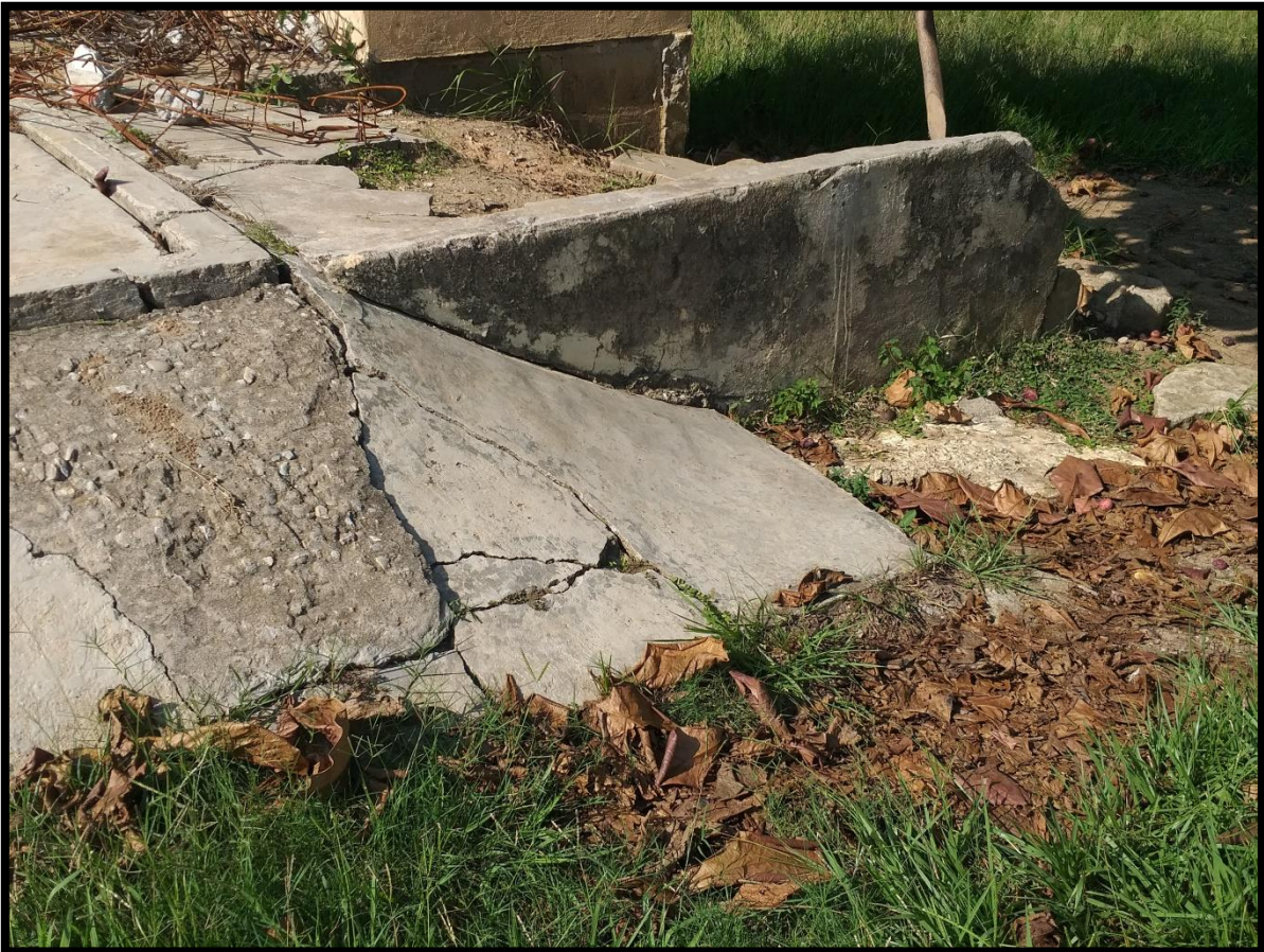
Figura 10 Rampa fisurada
