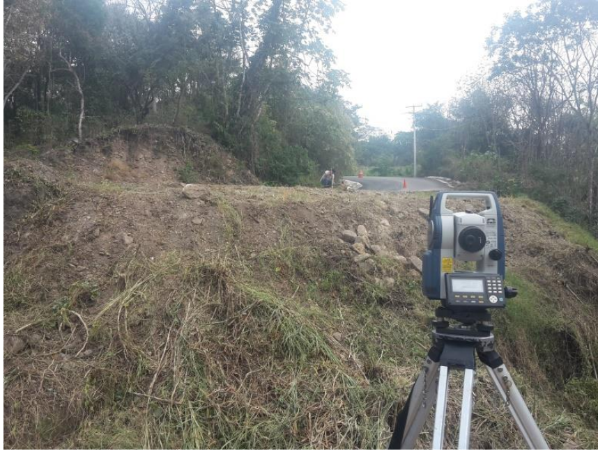
Imagen 3.2-4 Replanteo de Estribo 01, Lado Teopisca.
