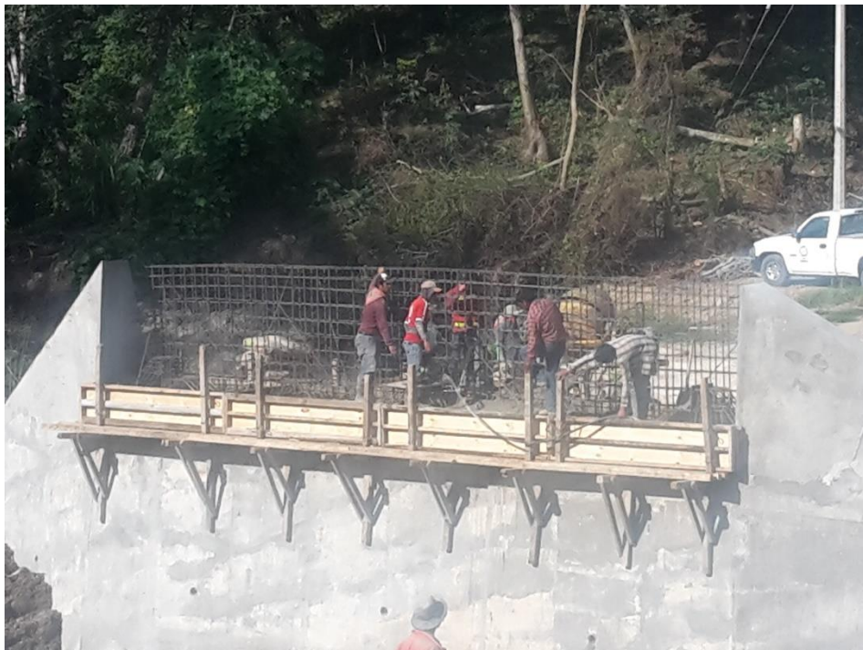
Imagen 4.1.6-4 Cimbrado y colado de Corona, respecto a Trazo y Niveles.
