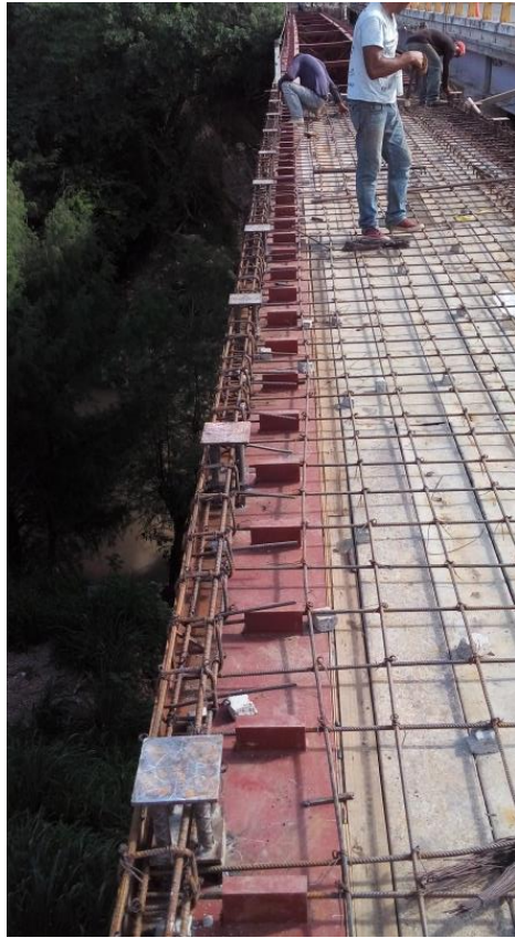
Imagen 4.1.11-1 Replanteo de Eje para Armado de Losa.
