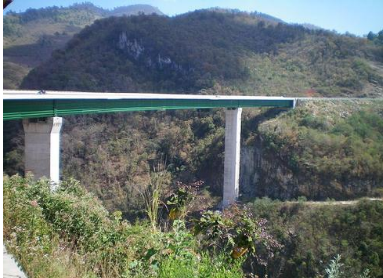
Imagen 4.2.-1 Puente San Cristóbal de las Casas.
