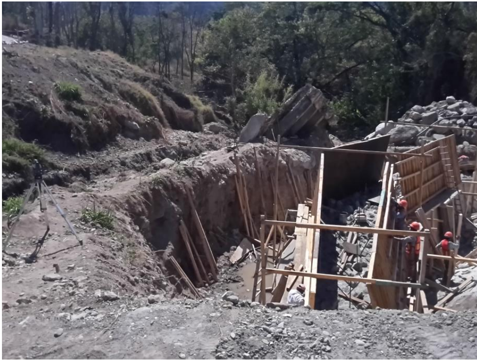
Imagen 4.1.3-2 Uso de puentes de madera para colocacion de puntos y nivel para lineamiento de Estribosy Aleros.
