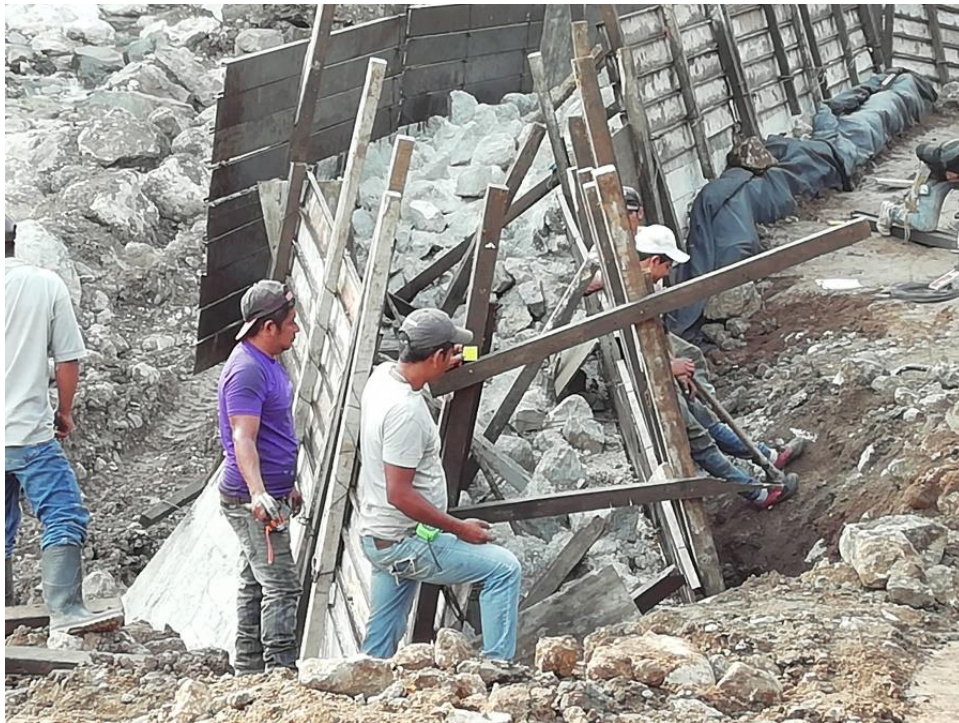
Imagen 4.1.3-3 Replanteo de Puntos y Niveles con Tarjeta Reflectora (Alero Izq).
