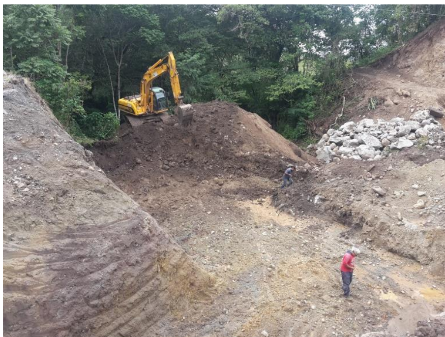
Imagen 4.1.1-4 Se observa que ha sido alcanzada la cota del piso para Desplante.
