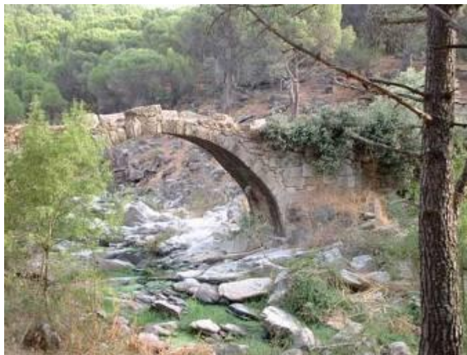
Imagen 1.6.2-5 Puente de Mamposteria de Piedra.
