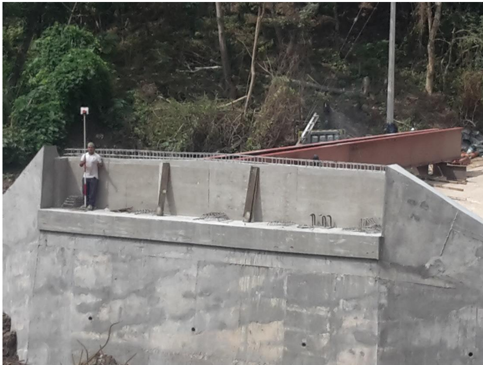
Imagen 4.1.7-2 Trazo y Nivelación para Construccios de Bancos y Topes Sísmicos.
