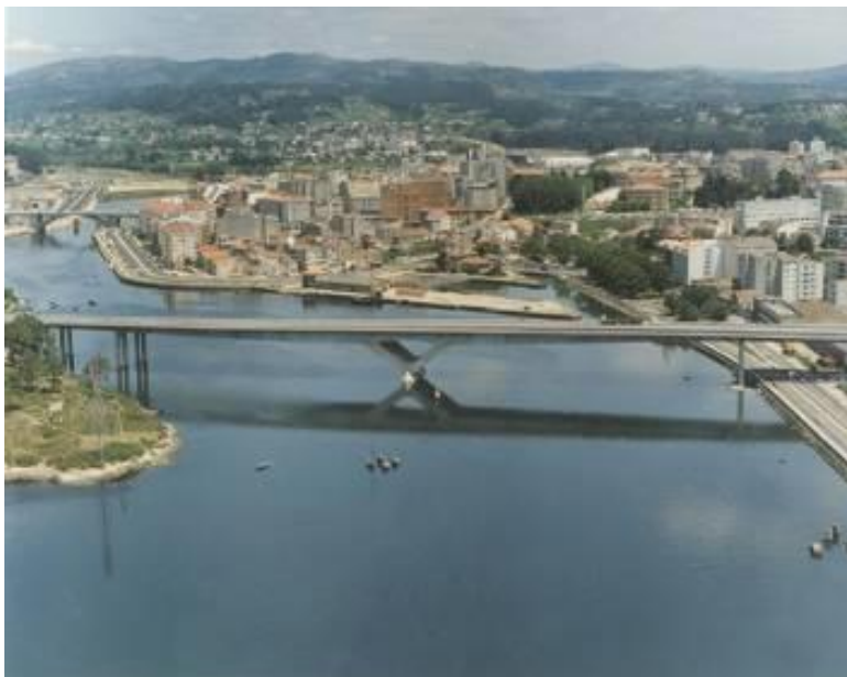
Imagen 1.6.2-1 Ponte Vedra, España. Con una luz de Vano mayor a 50m.
