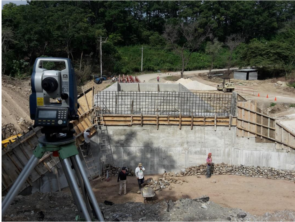
Imagen 4.1.6-3 Colocaciion de Armados de Corona y Muro de Respaldo respecto al trazo.
