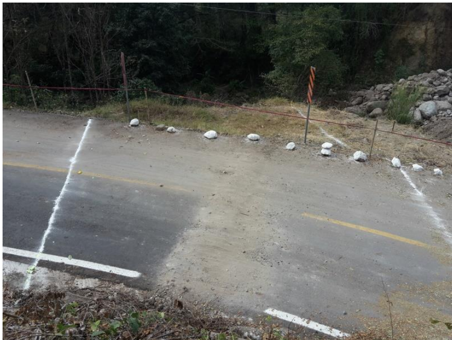
Imagen 3.2-5 Se unen los Puntos Replanteados con cal.
