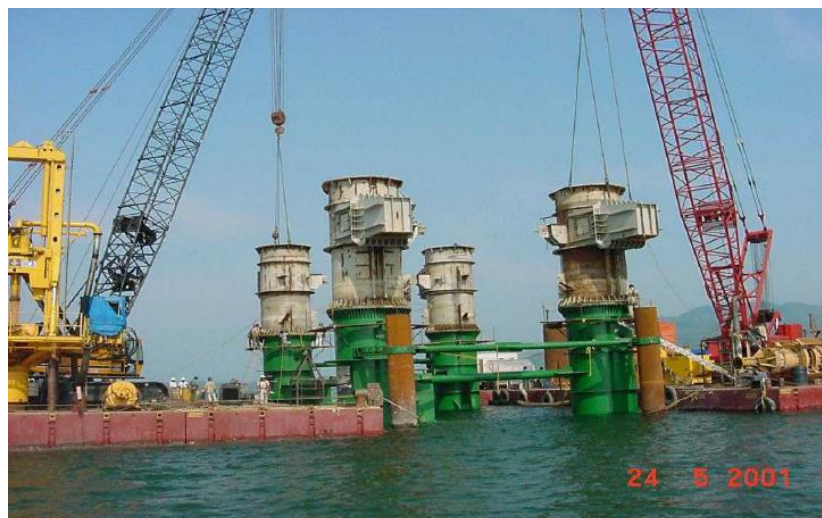
Imagen 4.3.4-6 Colocado de Jackets
