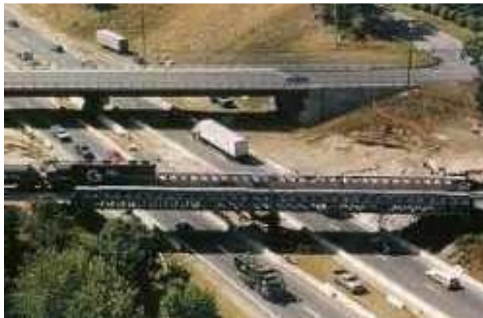
Imagen 1.6.2-2 Puente Caminero y Ferroviario.
