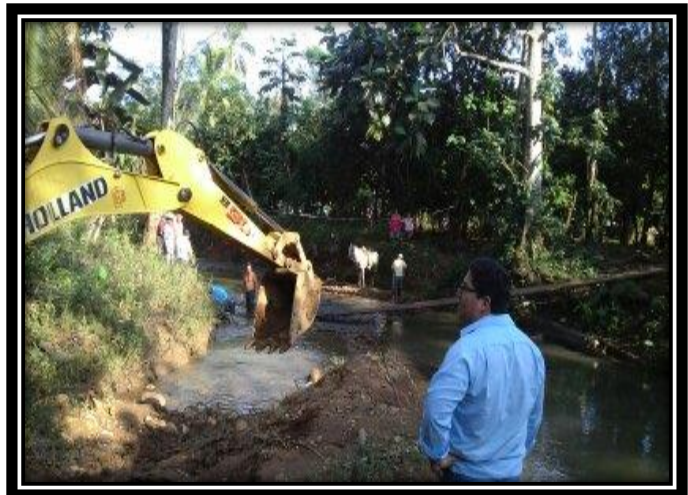
Ilustración 16 Desazolve de Arroyo en el Ejido Doctor Belisario Domínguez
