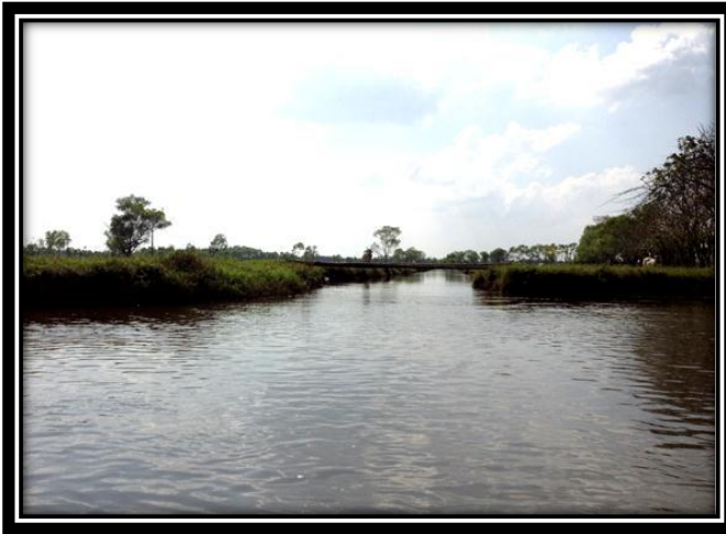
Ilustración 20 Dren Construido en el Río Pichucalco a la altura de Ejido Santa Cruz Tepate Abajo
