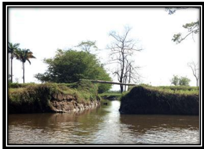
Ilustración 21 Dren Construido en el Río Pichucalco a la altura de Ranchería Las Mirandas
