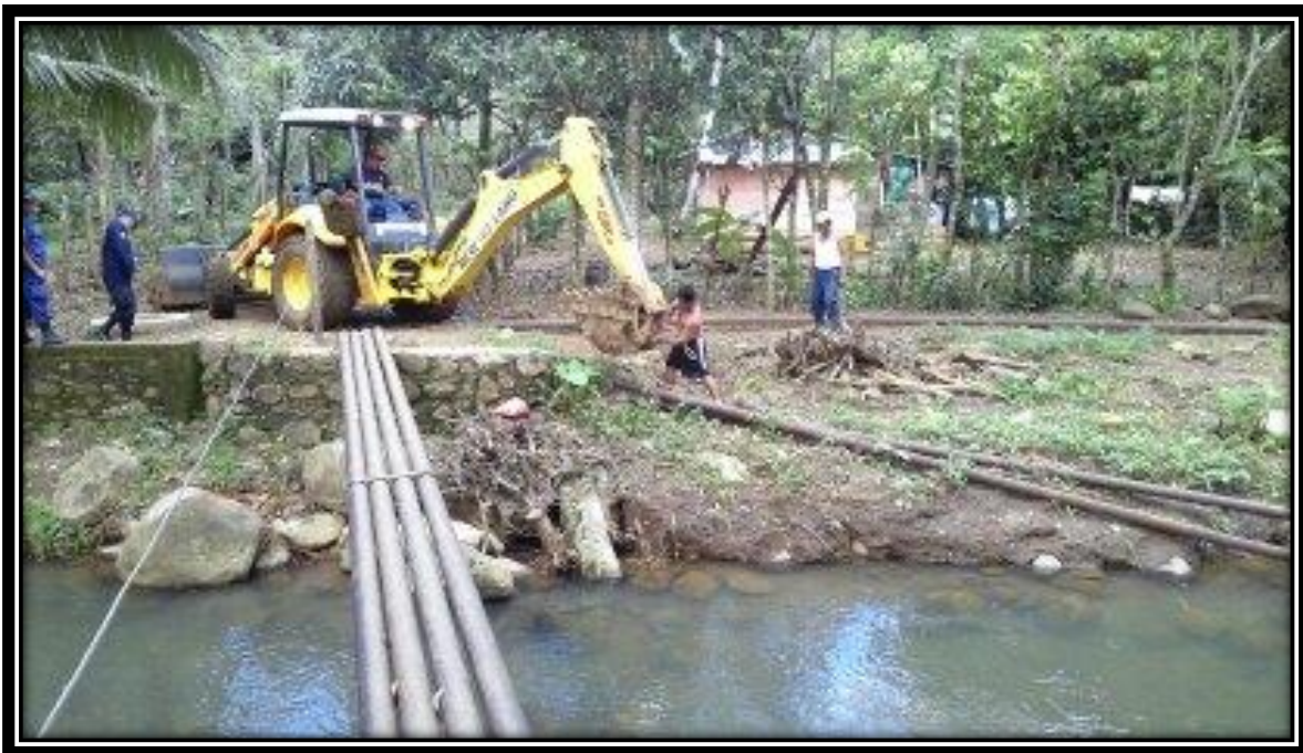
Ilustración 31 Desazolve de Arroyo en el Ejido Doctor Belisario Domínguez
