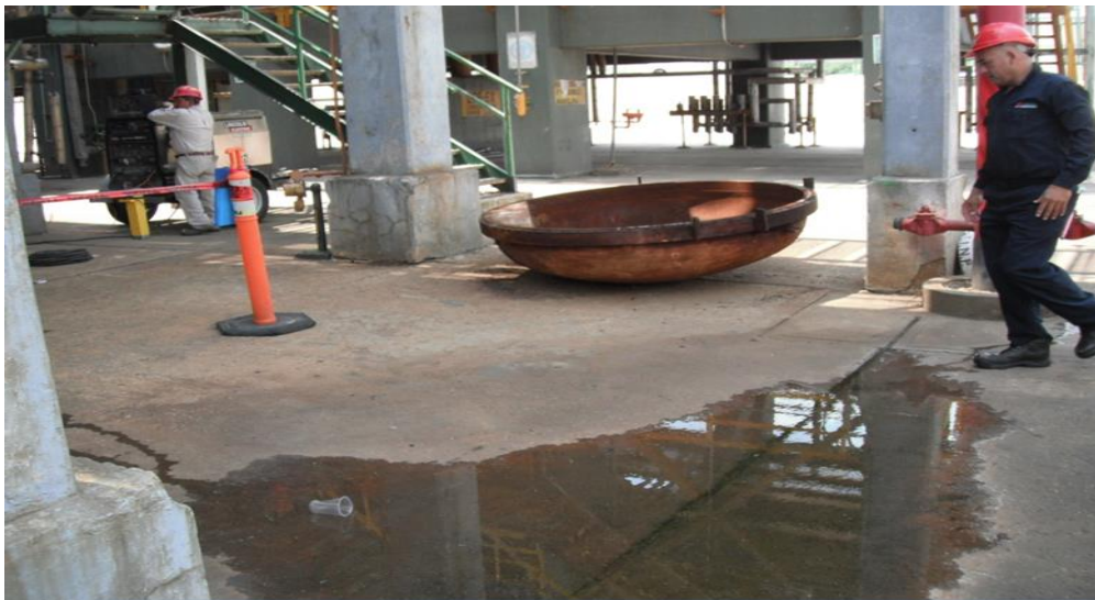
Ilustración 23 Humedad en el piso
