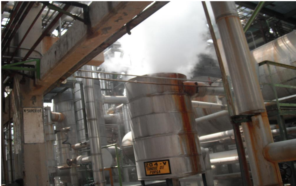
Ilustración 21 Fuga De Vapor En El Tanque De Purga 204 - V
