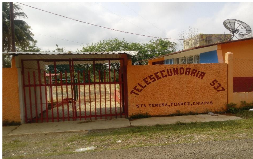
Figura No. 5 Fachada principal de la telesecundaria No. 537
