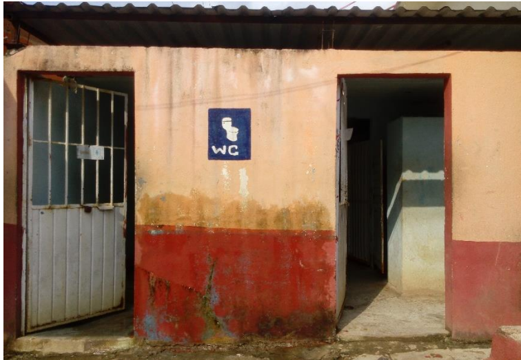
Figura No. 7 Fachada de los baños de la telesecundaria No. 537
