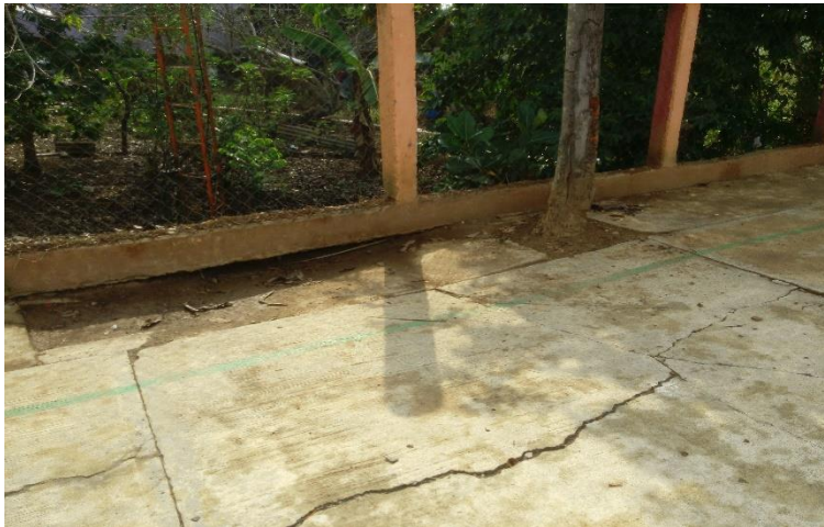
Figura No. 6 Partidura del suelo de la cancha de la telesecundaria No. 537
