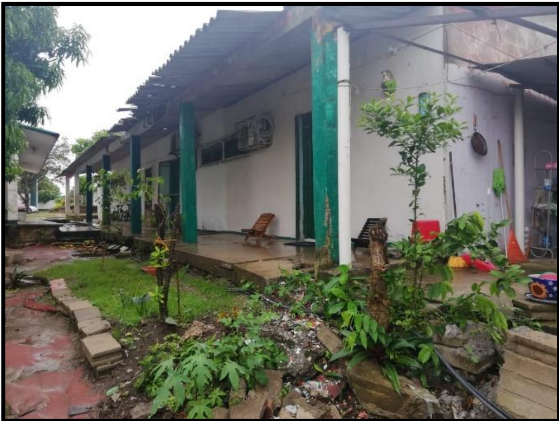
Figura 10 Pasillo frente a los salones. Fuente: con base a la información obtenida
