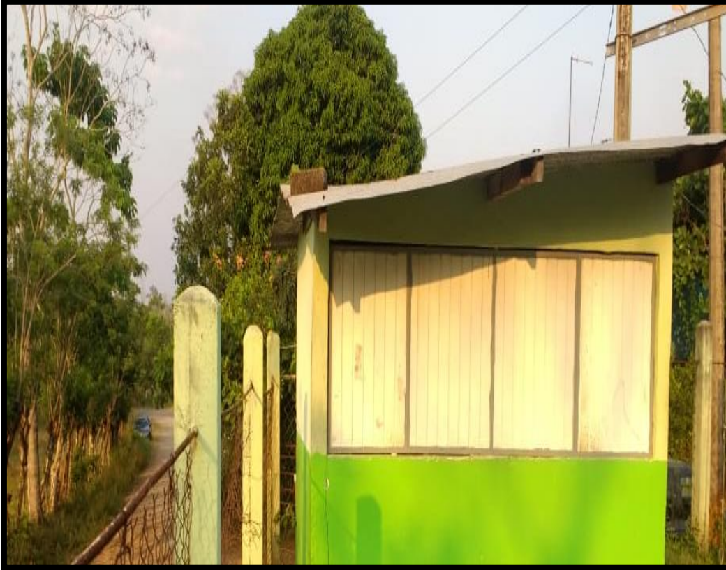
FIGURA 13 Escombros arriba del techo FUENTE en base en la información obtenida
