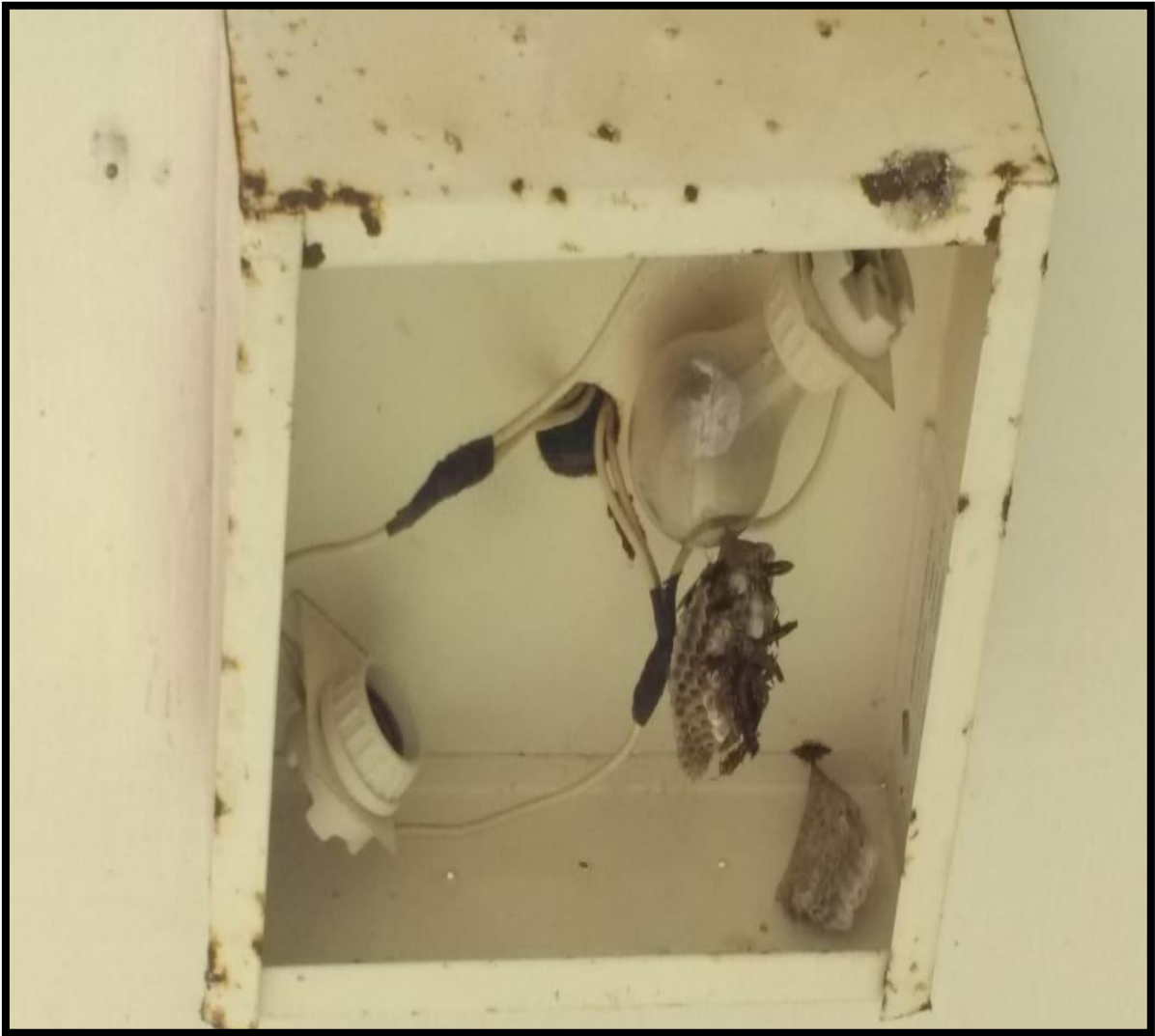
FIGURA 17 Riesgo de picadura de avispa. FUENTE en base a la información obtenida
