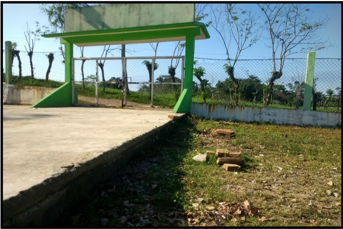
FIGURA 9 Desniveles del piso FUENTE en base a la información obtenida
