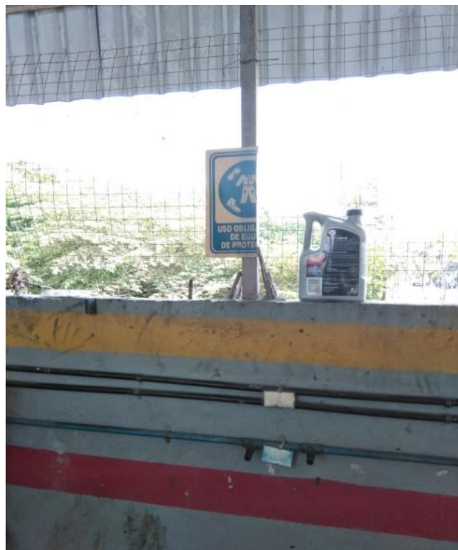
Figura 8 Muro del edificio
