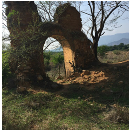
Figura 12. Cimientos de iglesia abandonada.
