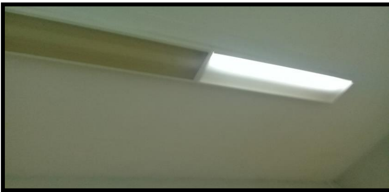
Figura 10. Lámparas fundidas Fuente: Con base a la información obtenida.
