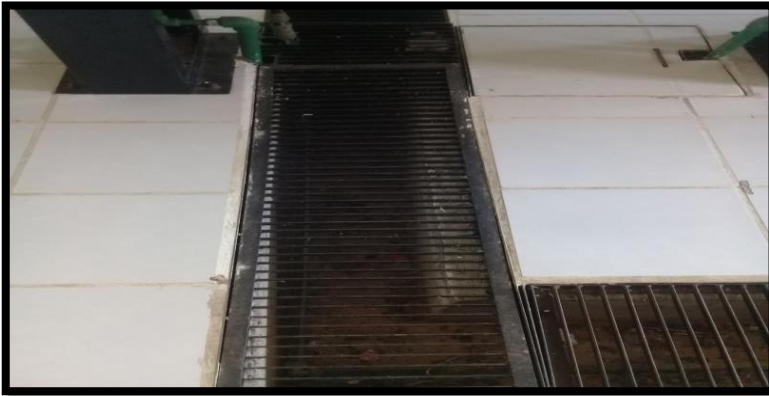
Figura 17. Parrillas de trincheras deterioradas Fuente: Con base a la información obtenida.
