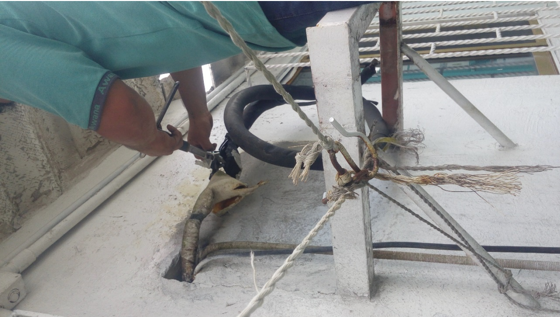
Figura-16 Corte de tubería
