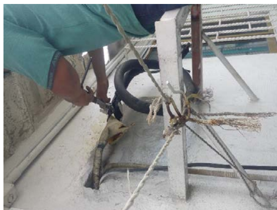
Figura-12 Corte de tubería
