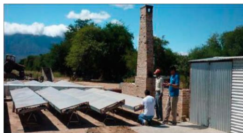
Figura 1.9 Secador con colectores dirigidos al norte [22].
