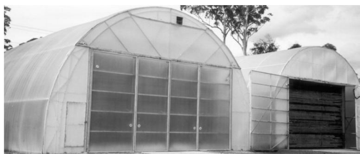
Figura 1.6 Secador solar tipo invernadero [19] .
