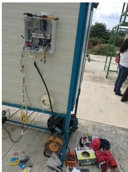
Figura 4.5 Instalación de Gabinete en el Secador solar.
