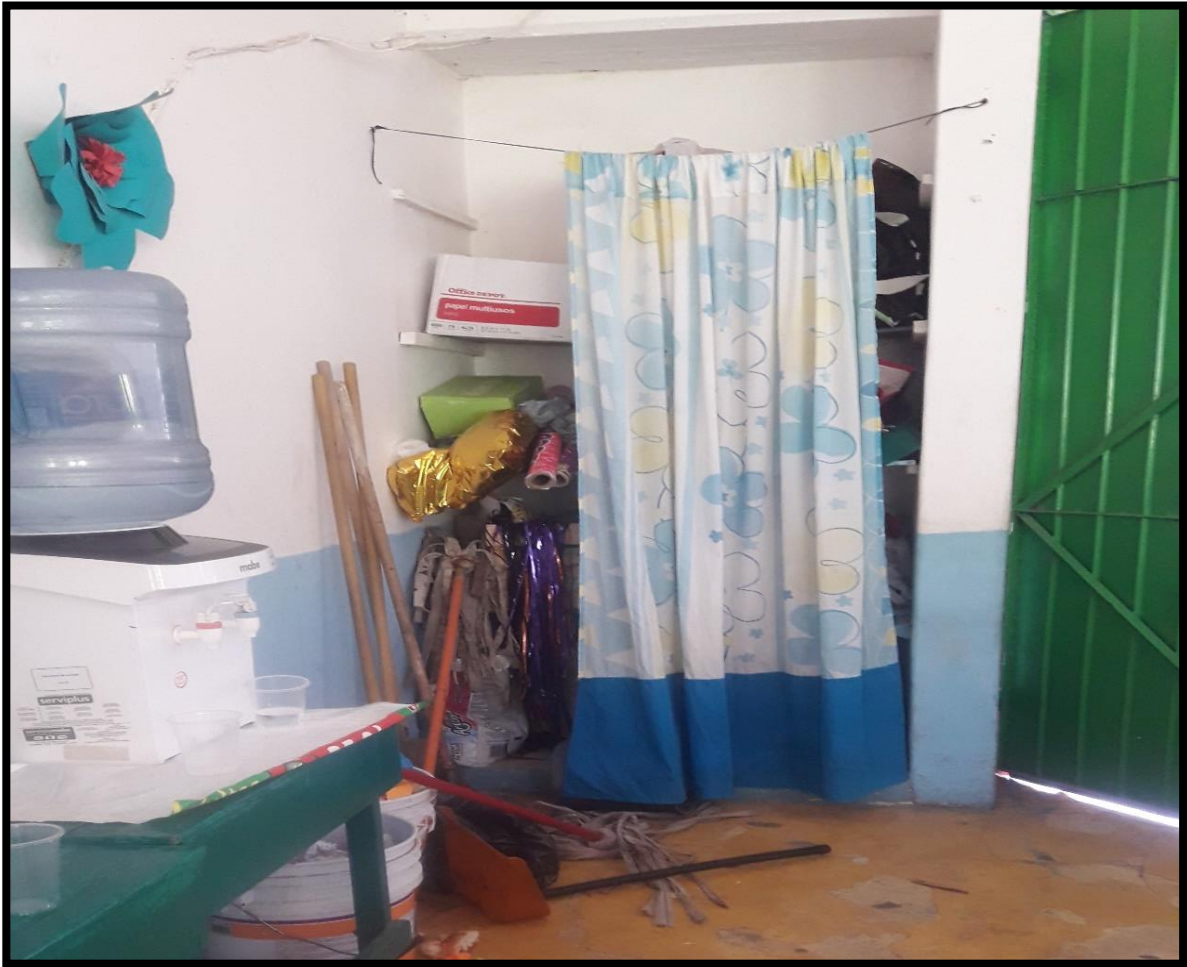
Figura 19 Falta de orden y limpieza.
