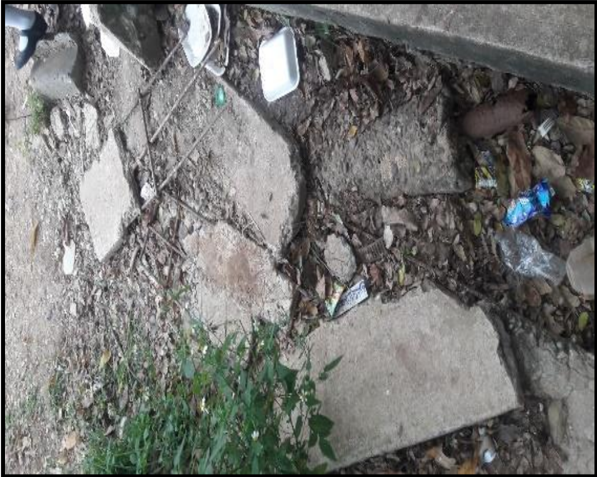
Figura 15 Resto de materiales de construcción.
