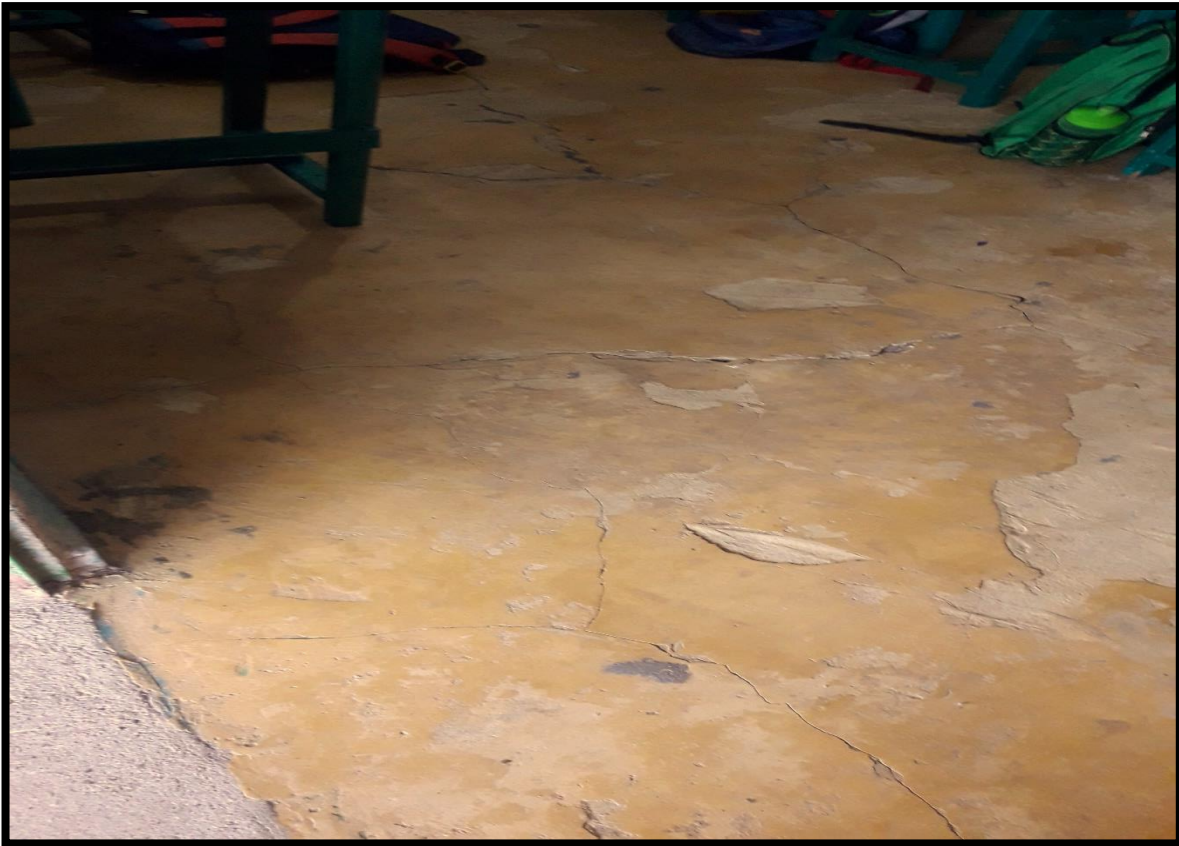
Figura 17 Pisos agrietados.
