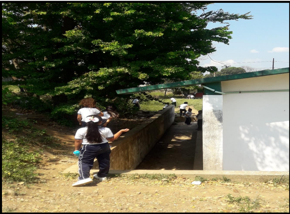
Figura 16 Muro de contención.
