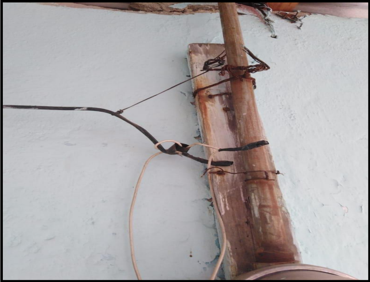
Figura 36. Identificación de Riesgo por Incendio en la Col. Benito Juárez Fuente: Con Base a la Información Obtenida
