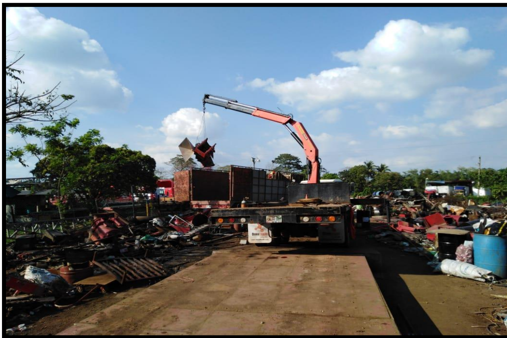
Figura.38 Traslado de material
