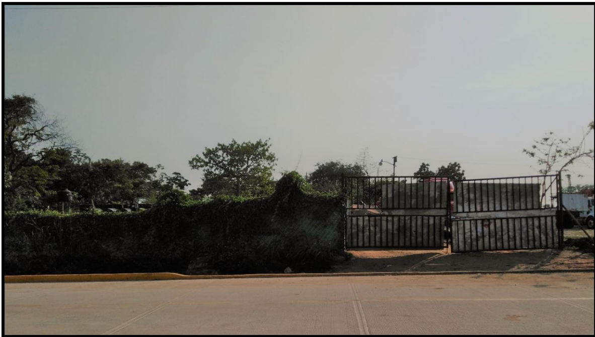
Figura 25 Instalación de la Empresa Reciclado Derivado de Chiapas
